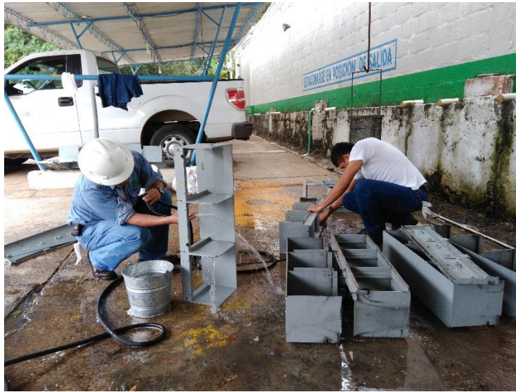
Figura 3. 16 Mantenimiento preventivo a cuna de tiristores.
