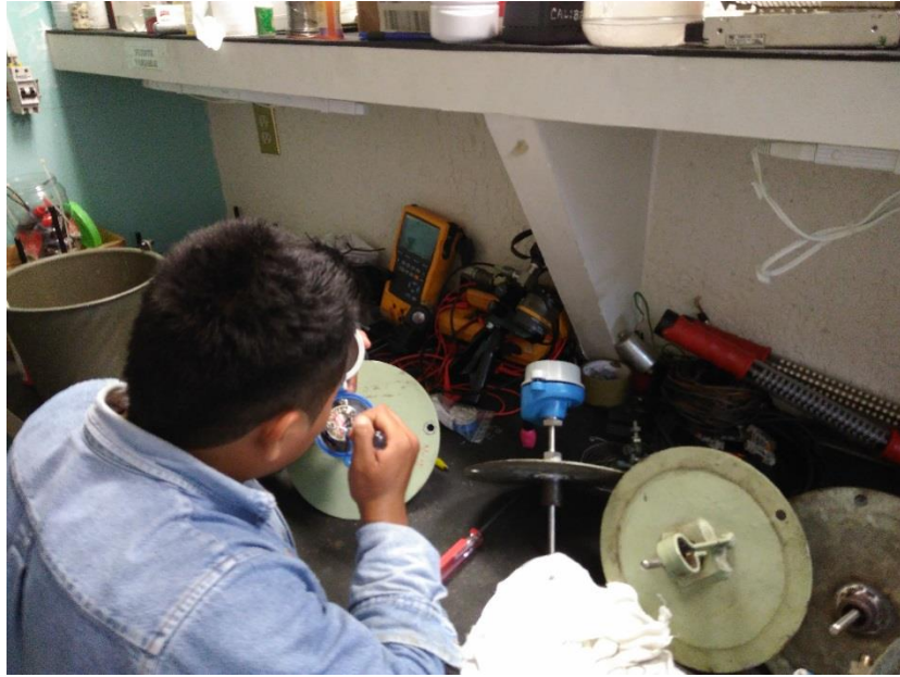
Figura 3.25. Mantenimiento a sensores capilares aire caliente del generador.
