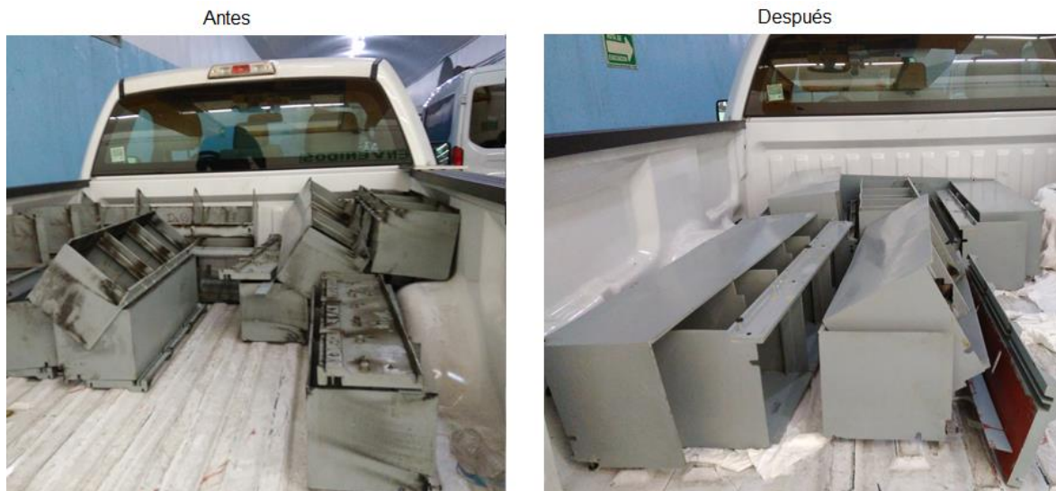
Figura 3.17. Placas y cunas de tiristores antes y después de la limpieza.
