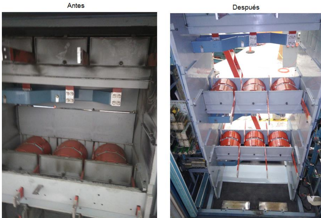
Figura 3.14. Antes y después de la limpieza de reactores y gabinete del puente de tiristores.
