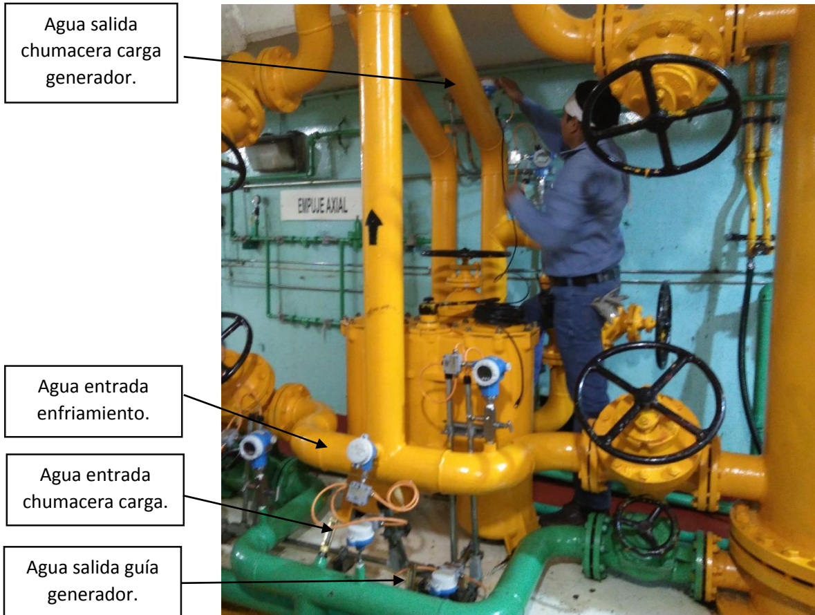
Figura 3.29. Calibración de Sensores capilares.
