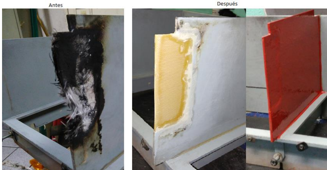
Figura 3.18. Mantenimiento a cuna de tiristor.
