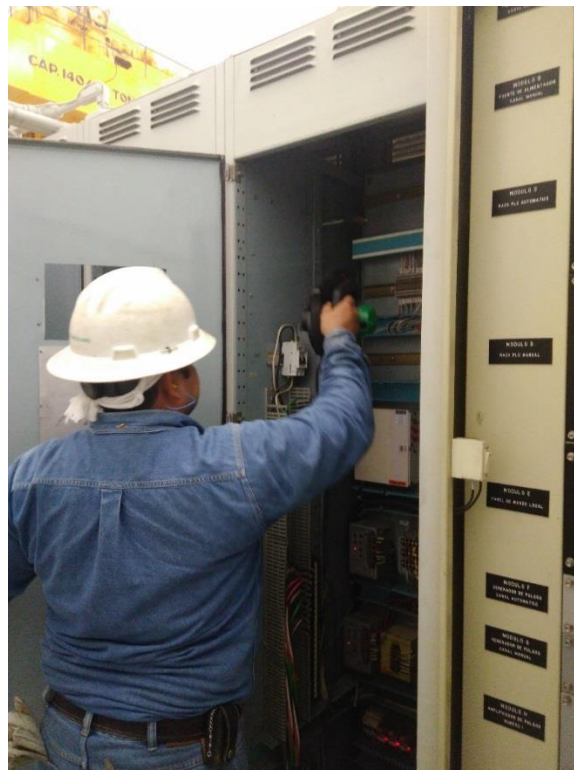
Figura 3.20. Limpieza de la unidad auxiliar.
