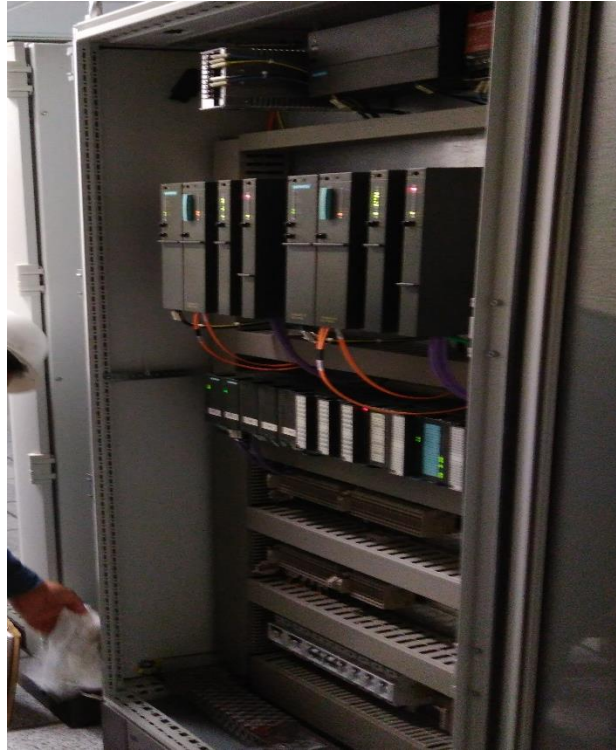
Figura 3.36. Limpieza al módulo remoto principal.
