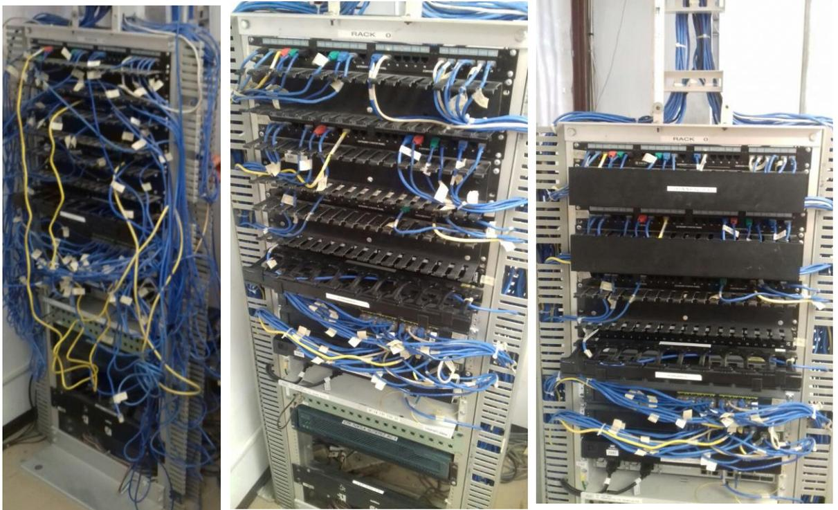
*Ilustración 8: En esta ilustración se muestran las condiciones de cómo se encontraba estructurado el SITE del primer piso de las instalaciones de TELMEX, y como se encuentra después de haber reestructurado los cables de parcheo.*
