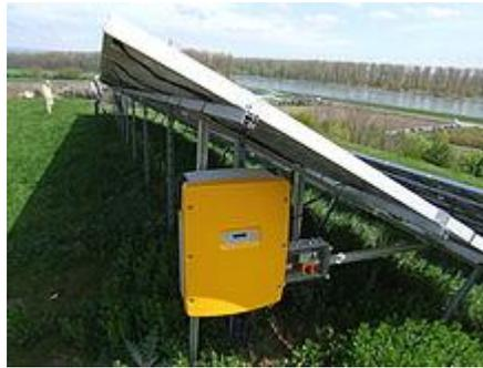
**Fig. 2.3.- Inversor conectado a un panel solar.**
