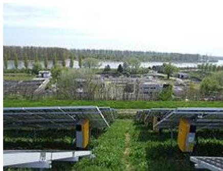
**Fig.2.4.- Red de paneles solares con su respectivo inversor solar.**
