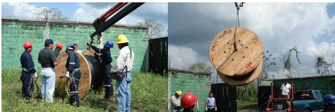
Fig.33.- Traslado de los carretes de fibra para su colocación en el vehículo especial para llevar a cabo el tendido.
