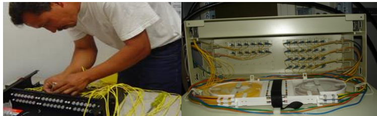
Fig.36.- Distribuidor óptico
