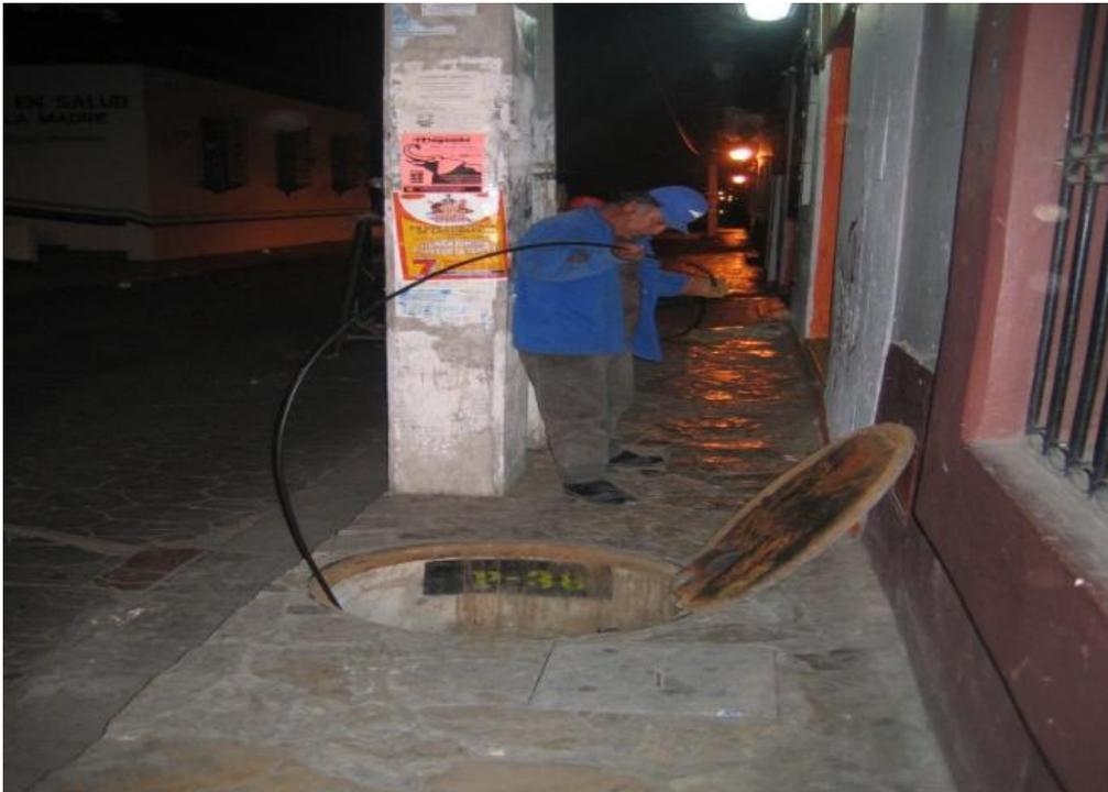
Esta actividad consiste en el tendido del cable de fibra óptica acorazado del edificio de zona a la transición aérea-subterránea, la cual será de acuerdo a las especificaciones y recomendaciones del fabricante del cable de fibra óptica acorazado, conformándose por las tareas siguientes:
