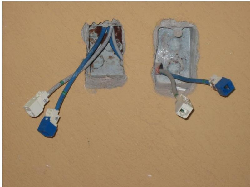
Esta actividad consiste en el suministro e instalación del Jack para salida telefónica, el cual estará rematado al cable UTP que estará montado en escalerilla
