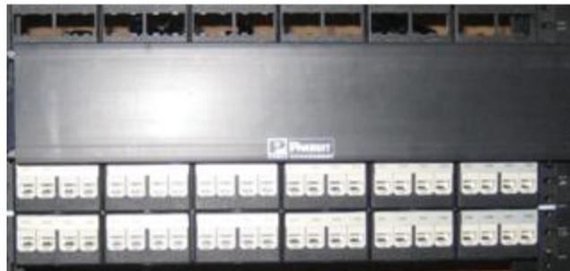
Esta actividad se refiere al suministro e instalación de panel de parcheo modular de 48 puertos (indicado en la pos. 9 del libro de materiales), con sus respectivos accesorios de montaje de acuerdo a la distribución de los equipos de comunicaciones en el rack mencionados en la especificación seircvh
