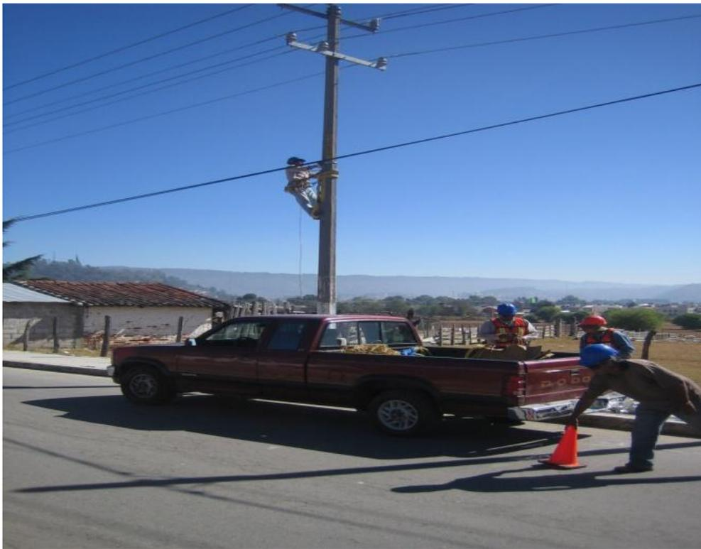
Esta actividad consiste en tendido, tensionado y rematado del cable de fibra óptica ADSS de la transición aérea-subterránea a edificio de distribución por la línea de 13.8 Kv, la cual será de acuerdo a las especificaciones y recomendaciones del fabricante, conformándose por las tareas siguientes:
