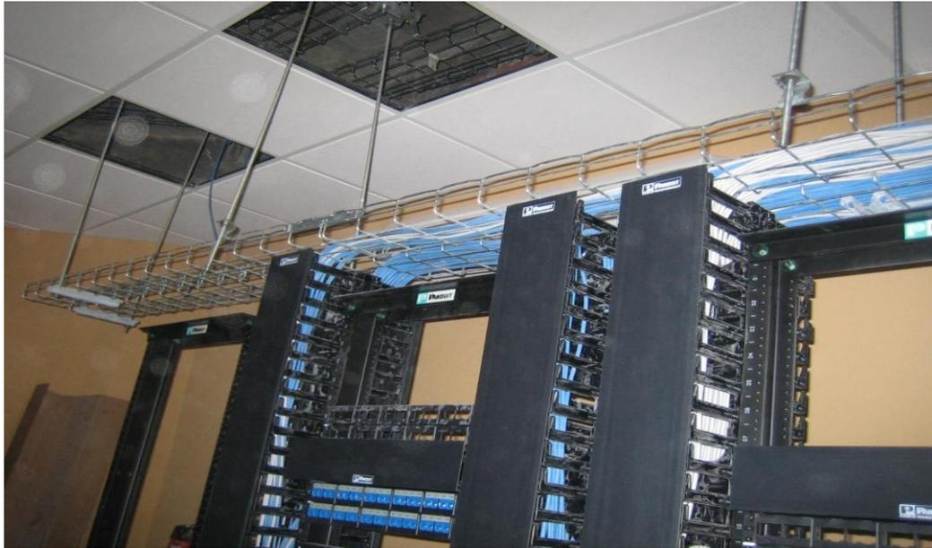
Esta actividad se refiere al suministro e instalación del organizador de cable vertical (indicado en el postulado 13 del libro de materiales) en el rack de comunicaciones con sus respectivos accesorios de montaje, por donde se colocaran y acomodaran los cables de manera ordenada evitando cruces, dobleces, cables suspendidos u apretados.
