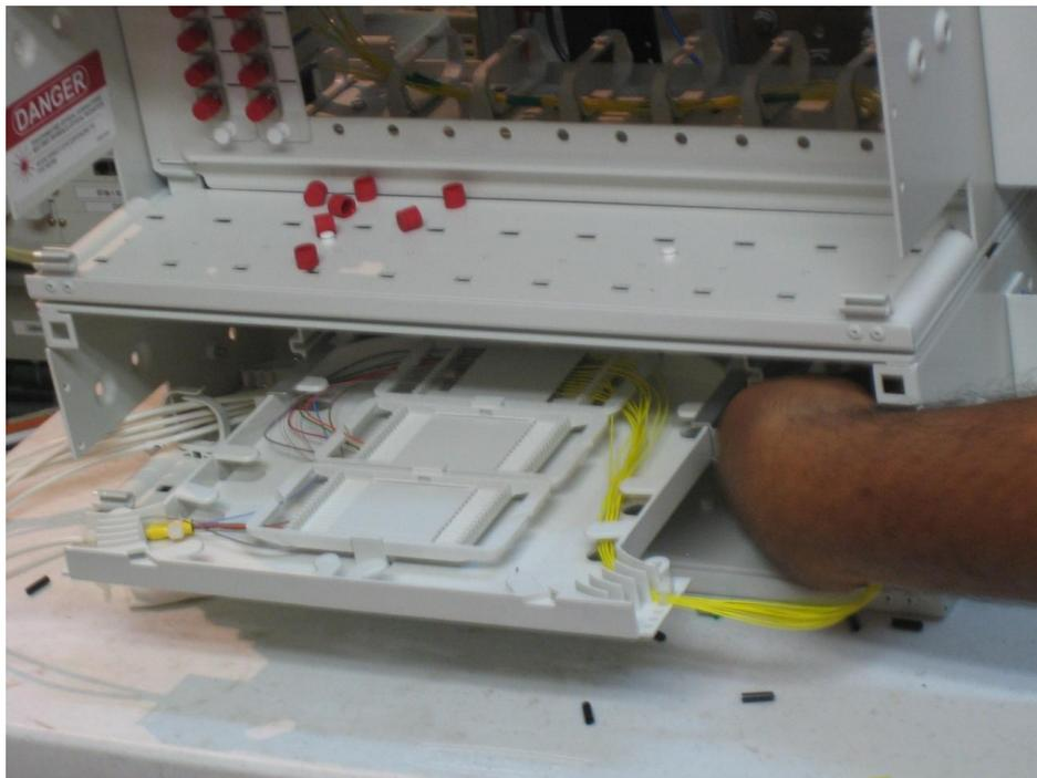
Esta actividad consiste en la instalación del distribuidor óptico en la sala de comunicaciones del edificio distribución y caseta de control de la subestación san Cristóbal, la ejecución de los trabajos requeridos para realizar los empalmes de las fibras ópticas de acuerdo a las especificaciones y recomendaciones del fabricante, conformándose por las tareas siguientes:
