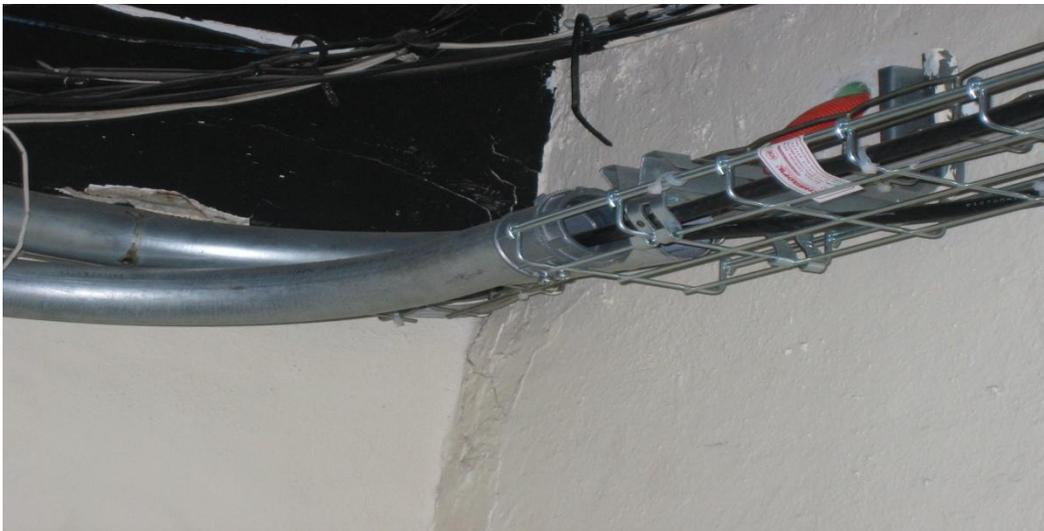
Esta actividad consiste en el tendido del cable de fibra óptica ADSS por ductos en el edificio de distribución y acorazado en ductos en el edificio de zona, la cual será
