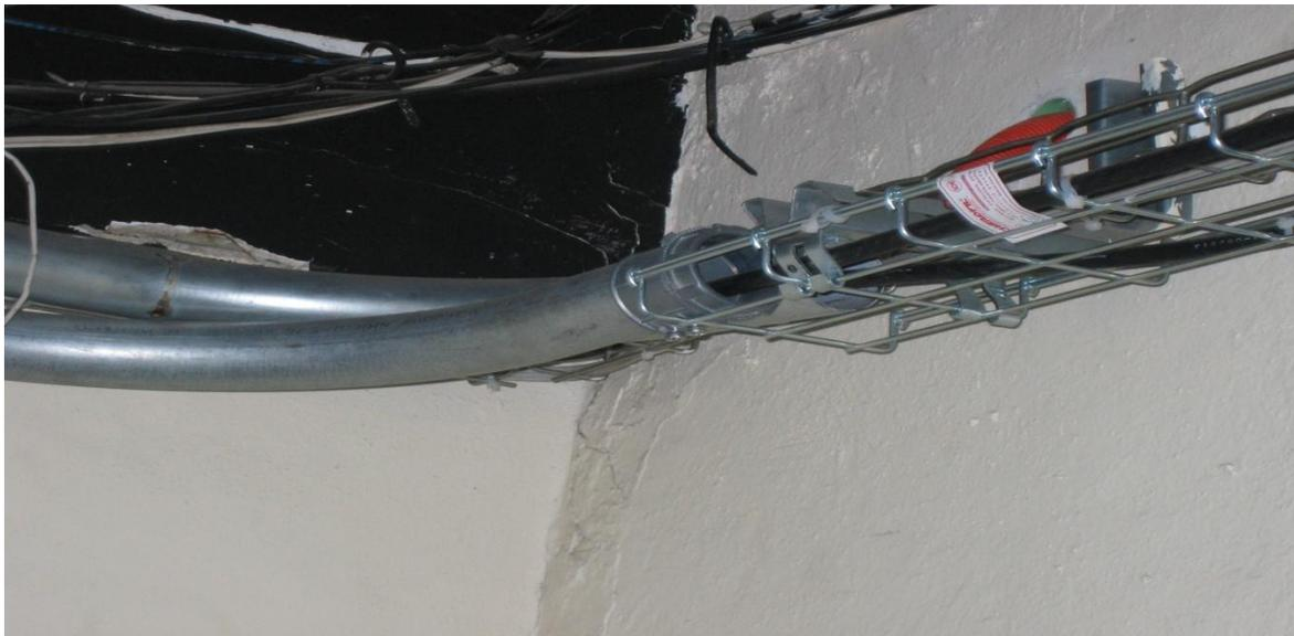
Esta actividad consiste en el tendido del cable de fibra óptica ADSS por ductos en el edificio de distribución San Cristóbal, la cual será de acuerdo a las especificaciones y recomendaciones del fabricante del cable de fibra óptica ADSS, conformándose por las tareas siguientes:
