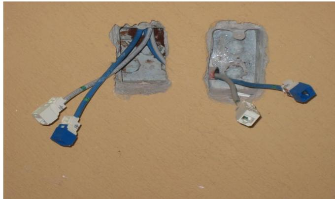
Esta actividad se refiere al suministro e instalación de conectores RJ45 (indicado en el postulado 10 del libro de materiales) e incluye el Rematado del cable UTP en conectores modulares RJ45, categoría 6 respetando la norma de estándar **Eia/tia t568b**, con sus respectivos accesorios de montaje.
