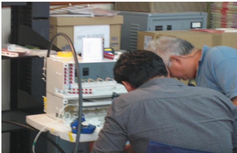
Esta actividad consiste en la realización de pruebas de atenuación del enlace con cable de fibra óptica instalado del edificio de zona a edificio de distribución, conformándose por las tareas siguientes:
