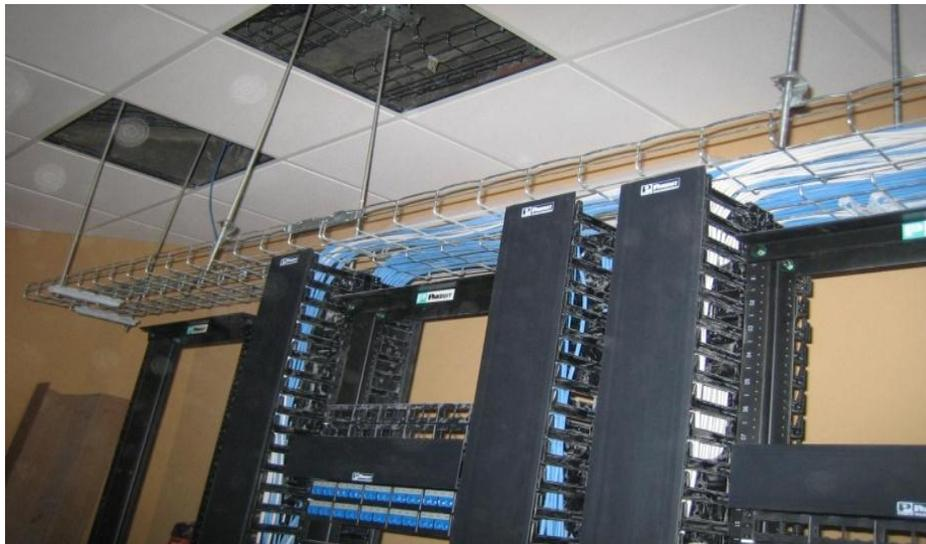
Esta actividad se refiere al suministro e instalación del organizador de cable horizontal (indicado en el postulado 12 del libro de materiales) en el rack de comunicaciones con sus respectivos accesorios de montaje, por donde se colocaran y acomodaran los cables de manera ordenada evitando cruces, dobleces, cables suspendidos u apretados en ambos lados del rack.
