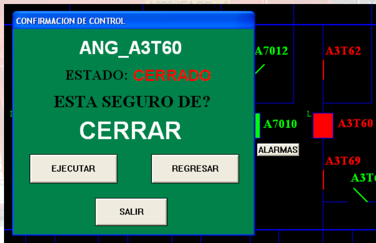
Figura 9.24: Confirmación del mando de Cierre del Interruptor A3T60.
