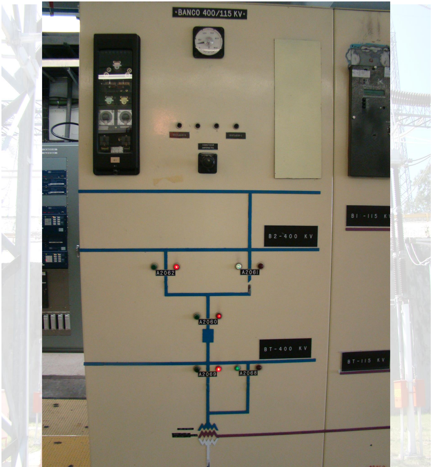
Figura 7.2: Diagrama unifilar de la bahía del I-A2060 en el tablero dúplex.
