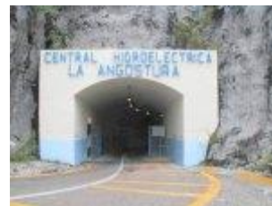
Túnel de Acceso a Casa de Maquinas
