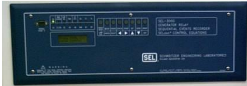
FIGURA 3.3: SEL - 300G RELEVADOR DE GENERADOR
