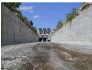
Vertedores – Vista desde canal de excedencia
