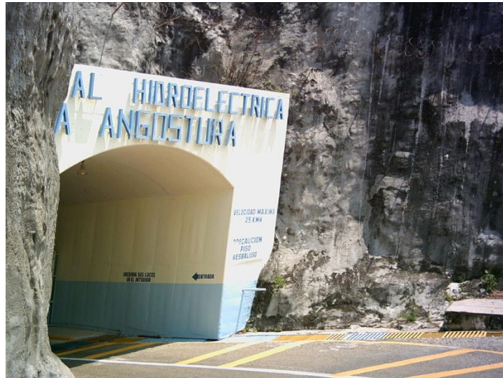
Figura 1: Entrada a casa de Maquinas.
