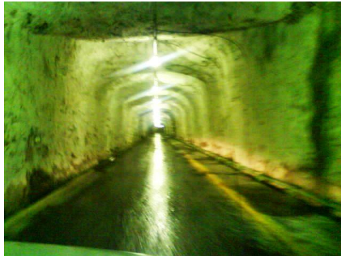
Figura 3: Túnel de acceso.
