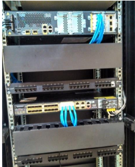
Figura 4.20 Conexión con cable UTP
