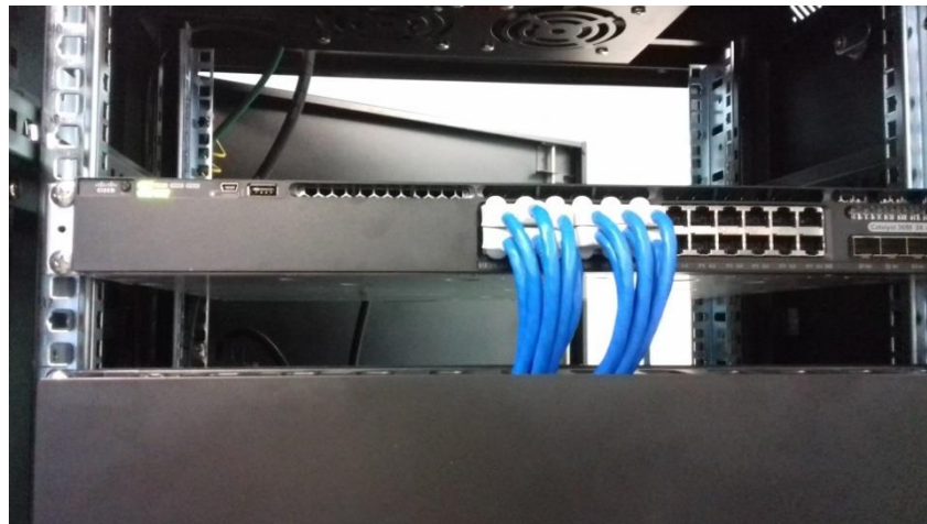
Figura 4.15 Conexión con cable UTP
