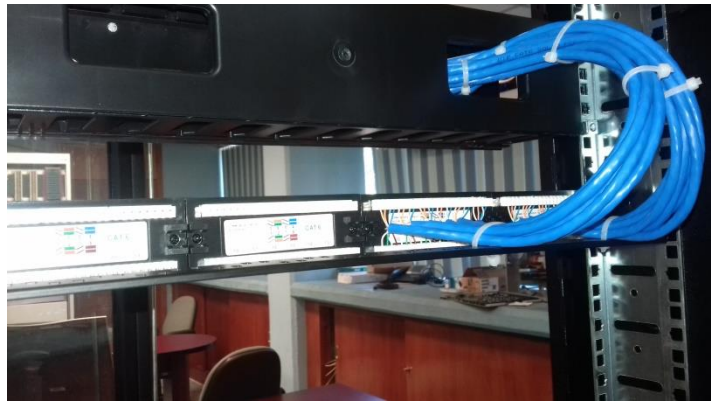
Figura 4.14 Parcheo del patch panel
