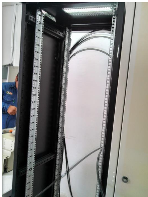
Figura 4.18 instalación de F.O.
