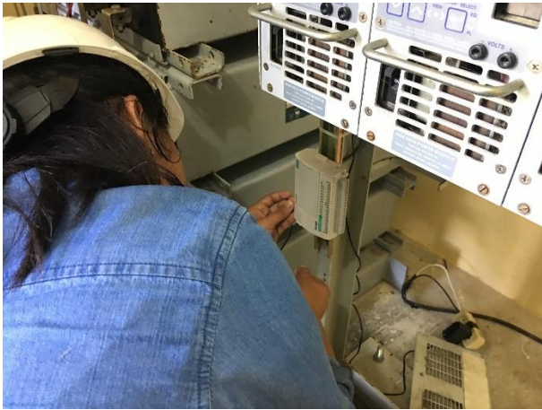
Figura 3.40 Instalación del equipo IoLogik/MOXA en la caseta “Mactumatzá”.
