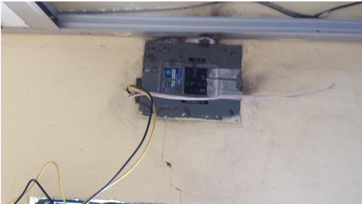
Fig. 9 Se ve como se encontraban las instalaciones eléctricas en la caseta carrier donde se encuentra el switch de 24 puertos y el aire acondicionado.
