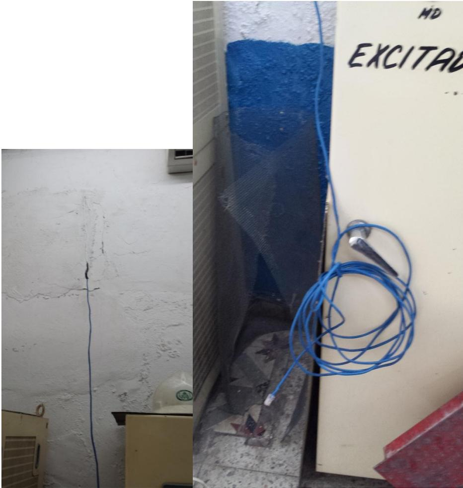
Fig. 8 se muestra como estaban los cables en mal estados y mal acomodados en la oficina del operador y la oficina del superintendente.
