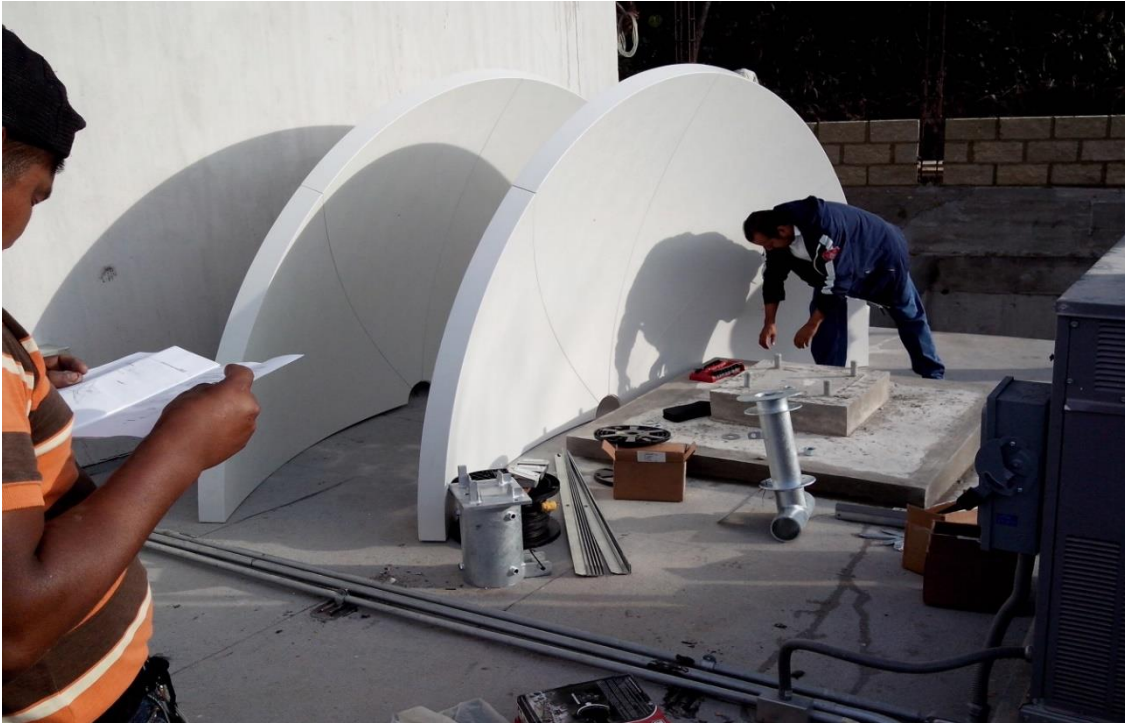
Fig. 3.23 Construcción de las antenas parabólicas, alineamientos y azimut.
