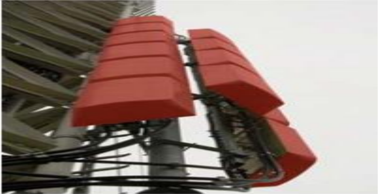
Figura 3.2 antena de transmision
