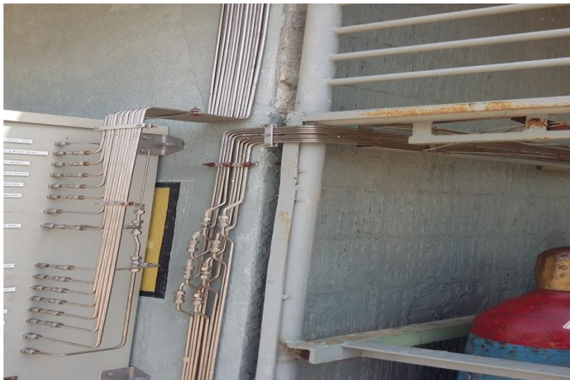
Figura3.19 Conexiones Típicas Tubing Al Sistema De Acondicionamiento.
