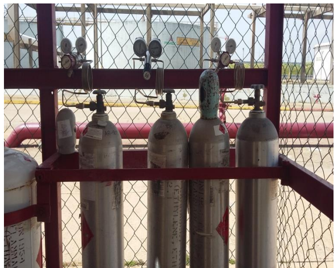
Figura 3.32 Instalación Gases De Calibración.
