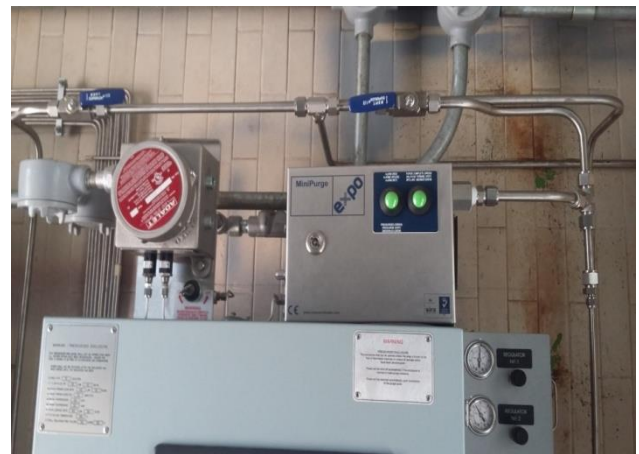
Figura 3.30 Verificación Instalación Purga.
