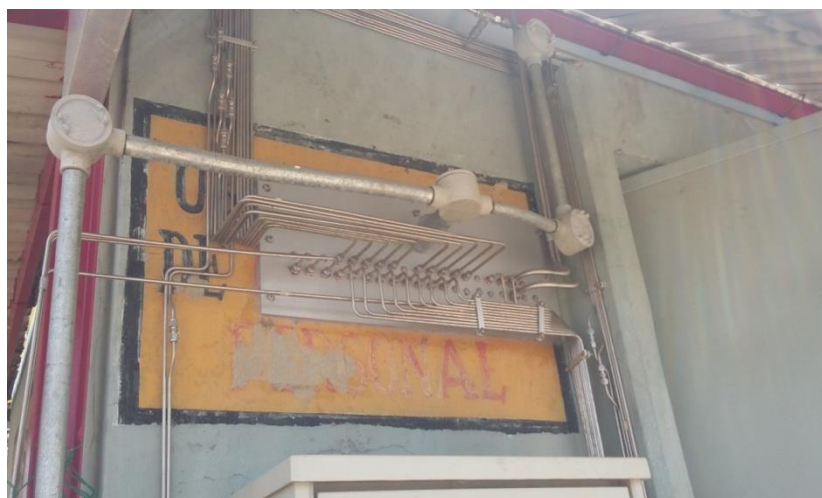
Figura 3.20 Conexiones Típicas Tubing Al Sistema De Acondicionamiento Corriente 1 y 2.
