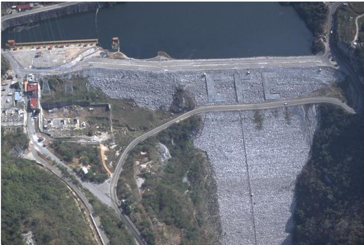
ILUSTRACIÓN 3- CORTINA DE ENROCAMIENTO
