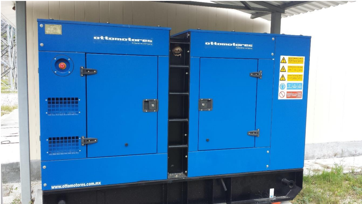
ILUSTRACIÓN 74-GENERADOR DE EMERGENCIA
