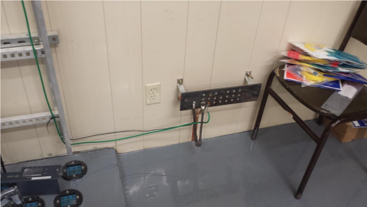
ILUSTRACIÓN 82-SISTEMA DE TIERRAS CASETA SHELTER
