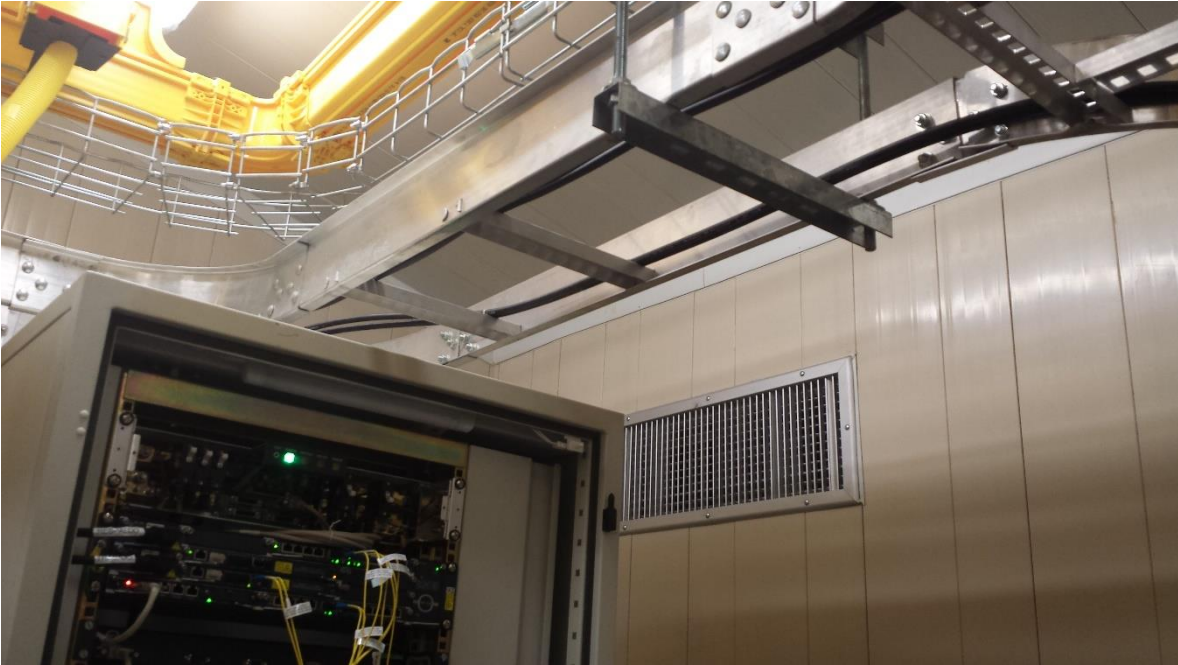
ILUSTRACIÓN 77- GABINETE MPLS-TP Y SALIDA DE A/C
