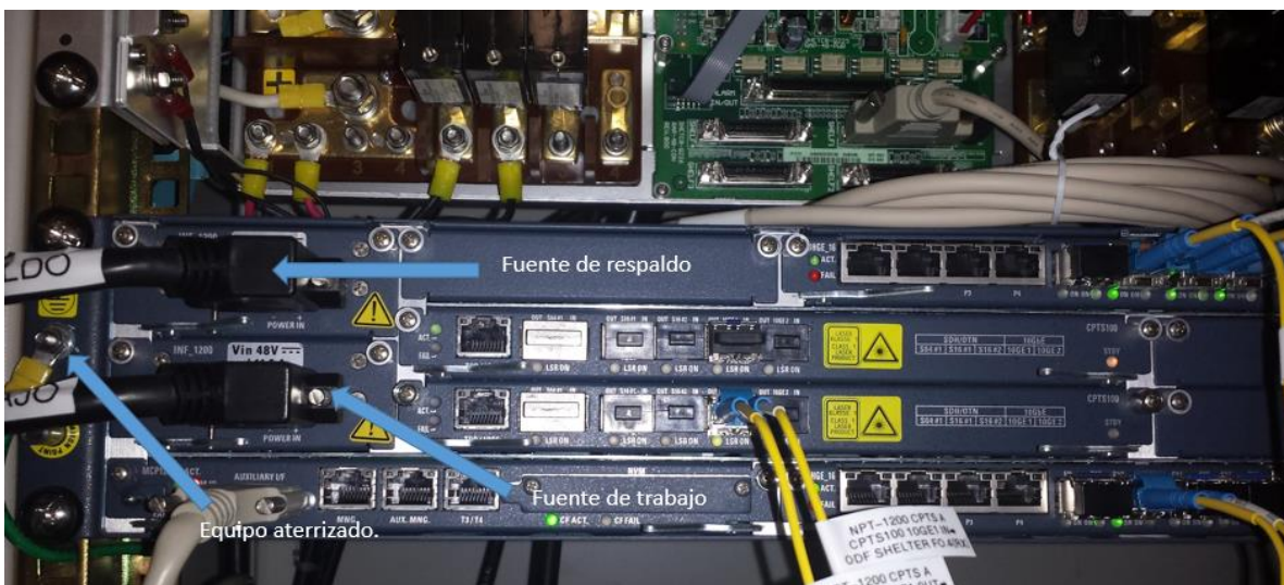
ILUSTRACIÓN 86-CONEXIONES NPT-1200
