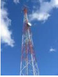
El transmisor se conecta a la línea de transmisión la cual esta desde la base de la antena hasta lo mas alto, en la parte superior de la torre se encuentra las antenas, las cuales irradian la señal.
