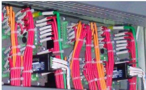
Fig. 3.1 Etiquetas utilizadas en los conductores
