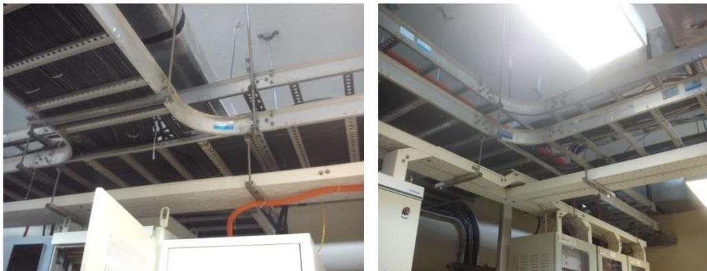
*Figura 4.3 escalerillas para la ubicación de cables de los diferentes equipos.*
