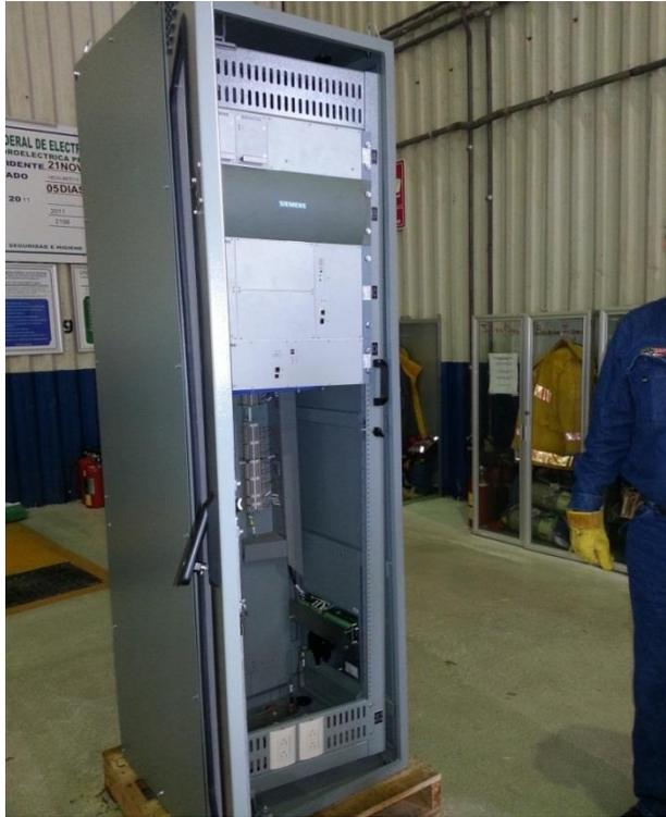
*Figura 4.2 equipo Powerlink en su gabinete y tablillas de conexiones*
