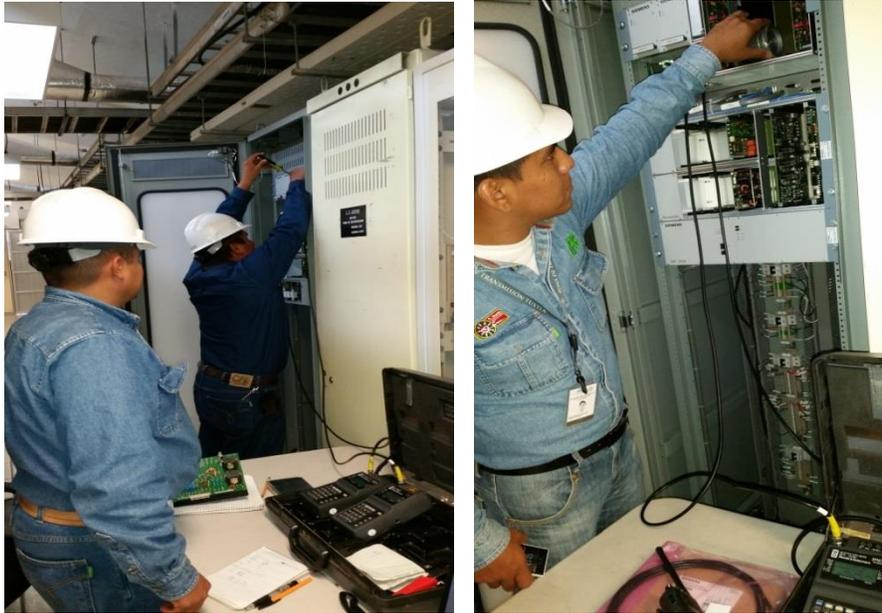
Figura 4.16 ajuste fino del filtro de transmisión
