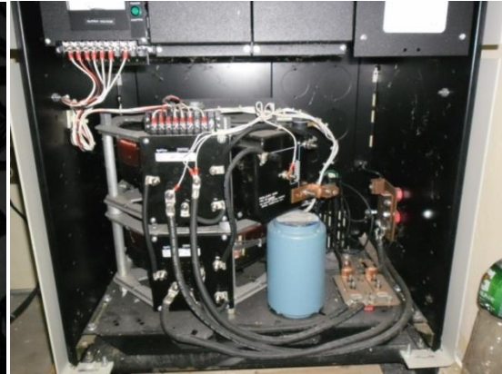
Figura 1.4 Regulador de voltaje monofásico.
