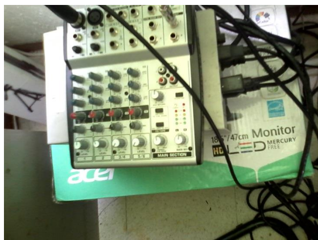
Figura 5.23 Instalación de la consola de audio.
