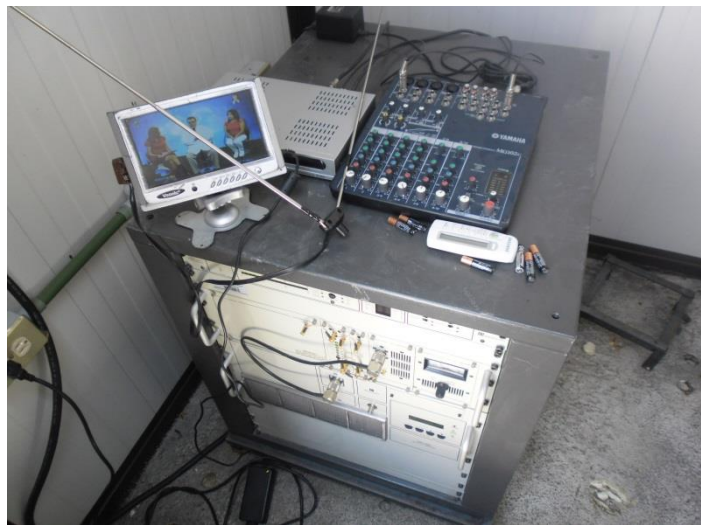
Figura 5.11 Transmisor amplificador, Receptor Satelital y Consola de Audio.
