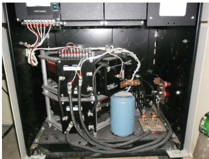
Figura 5.15 Regulador de voltaje monofásico.
