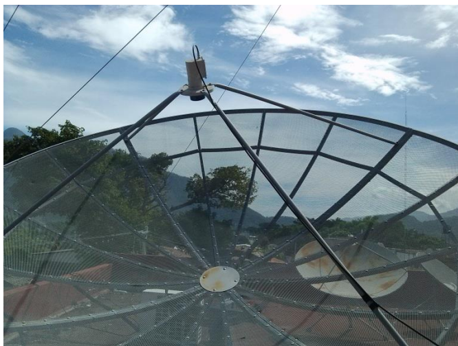
Figura 5.20 Antena parabólica y LNB nuevo.
