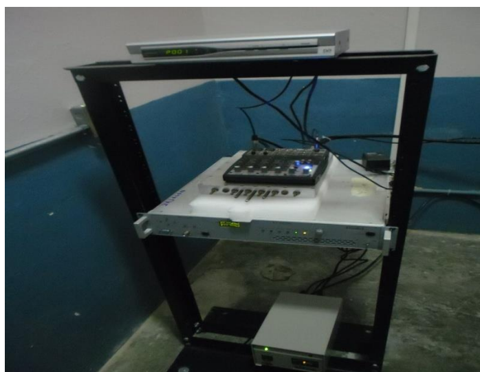
Figura 5.17Equipo de transmisión amplificador, consola de audio y receptor satelital.
