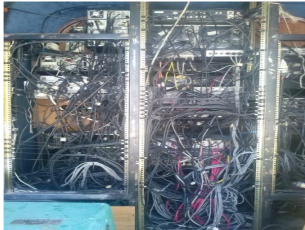
Figura 1.5 Etiquetado de Cableado.
