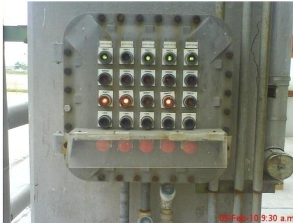
Fig.3.2. Panel de control en campo de las válvulas de grandes inventarios
