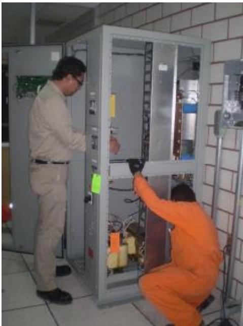
Fig. 3.19 Instalación y cableado de las UPS
