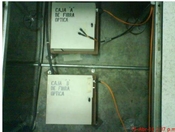
Fig. 3.23 Fibra Redundante y Principal
