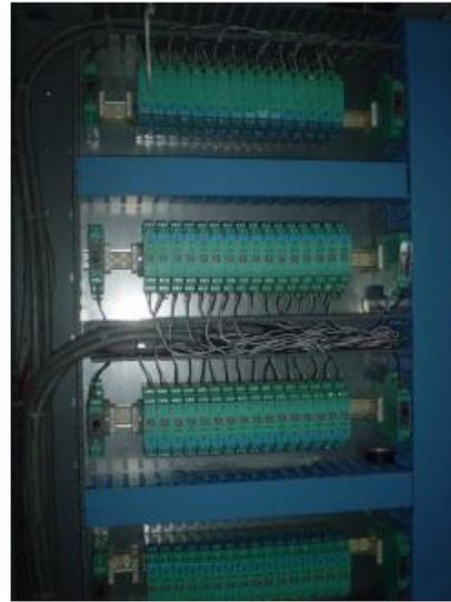
Fig. 3.17 Cableado de las barreras
