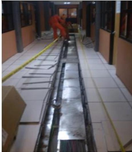
Fig. 3.15 Cableado en piso falso
