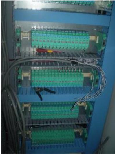
Fig. 3.17 Cableado de las barreras
