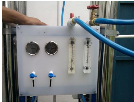
Figura 14. Colocación de instrumentos de medición y salidas.
