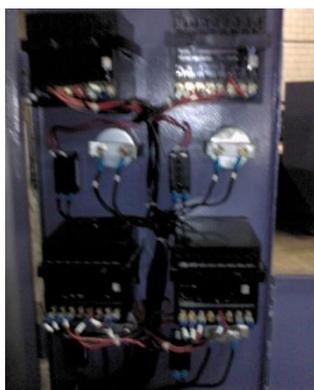
CONEXIONADO DE PIROMETROS Y AMPERIMETROS
