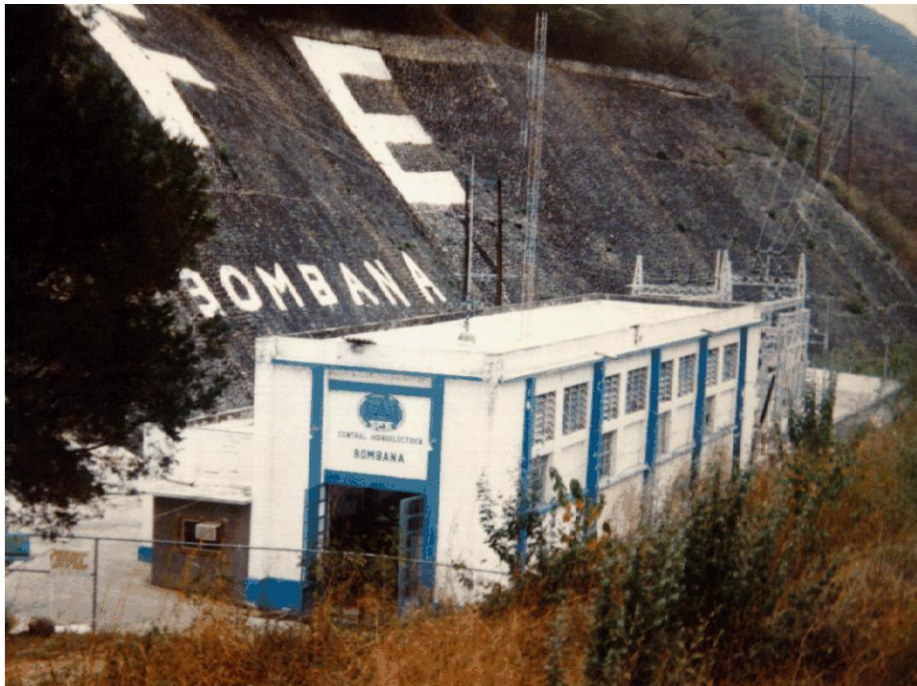
Fig.2.2.- Fotografía de la C.H. Bombaná localizada a 47Km de la ciudad de Tuxtla Gutiérrez.
