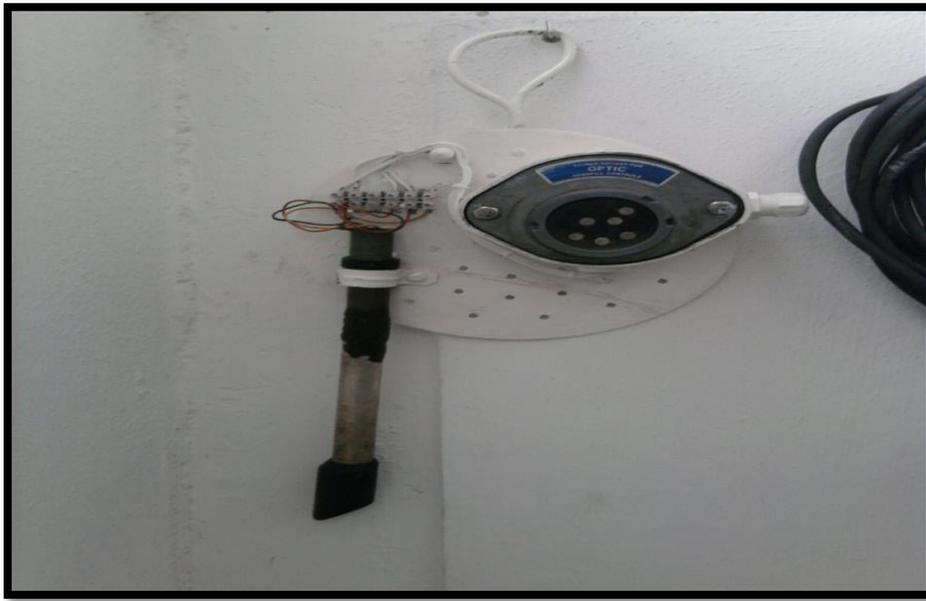
Figura 3.6. Sensor de nivel líquido
