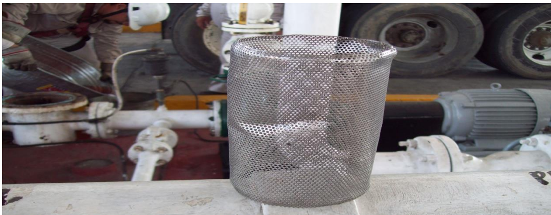
FIGURA 6 MALLA DEL FILTRO TIPO CANASTA
