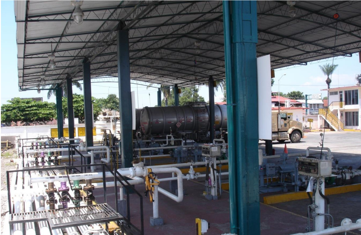
FIGURA 4 ISLA DE DESCARGA
