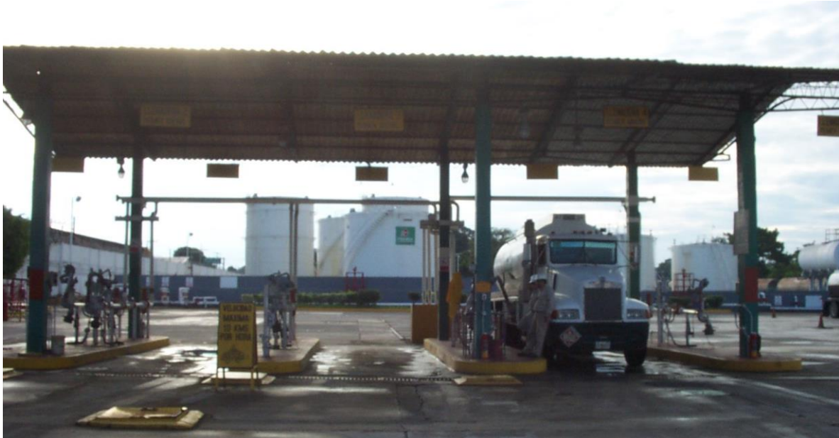
FIGURA 2. ISLA DE CARGA O LLENADERAS
