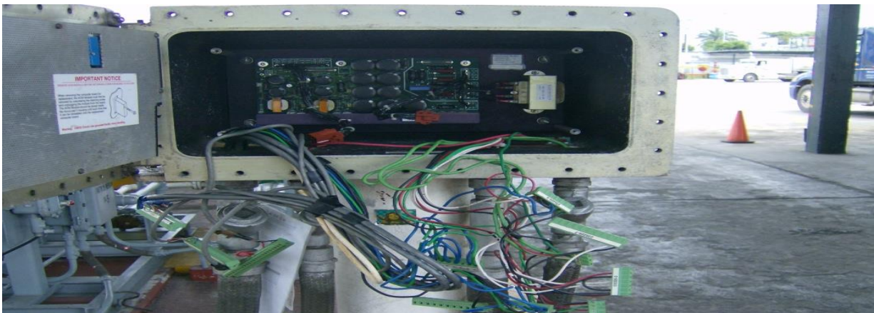
FIGURA 15 PARTE INTERNA DEL ACCULOAD
