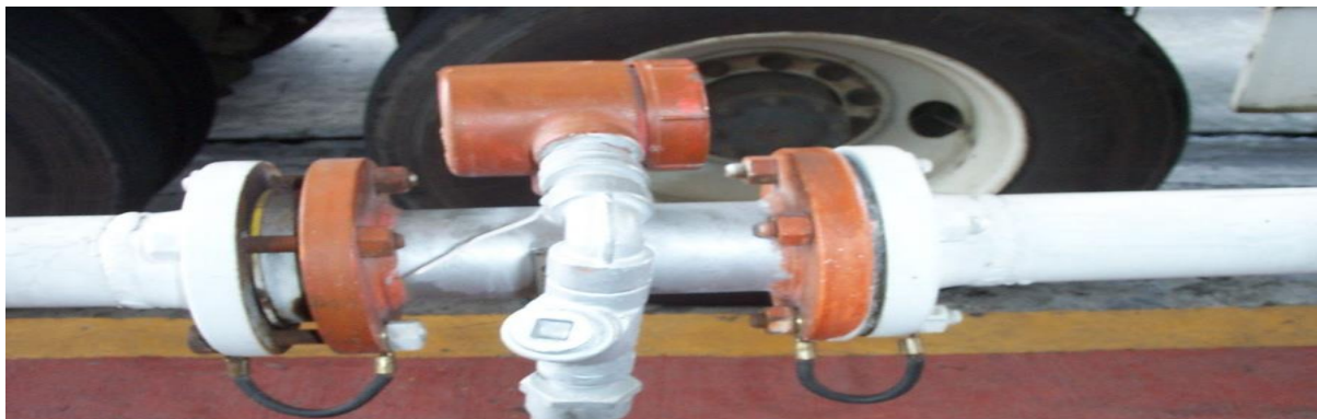
Figura 7 MEDIDOR TIPO TURBINA
