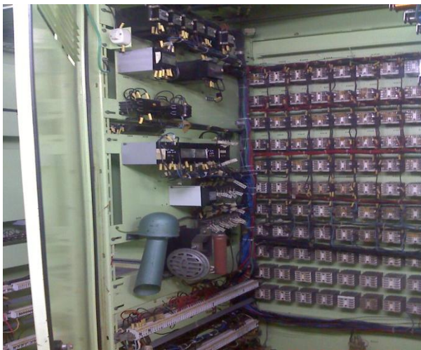
fig 3.6.4.-Gabinete DT4-4 y DT4-3 respectivamente: lógica de alarmas y disparos a base de relevadores
