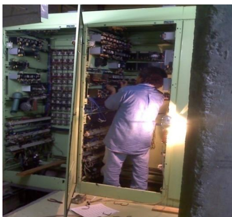
Fig 3.6.5.- Retiro de relevadores del gabinete DT4-3
