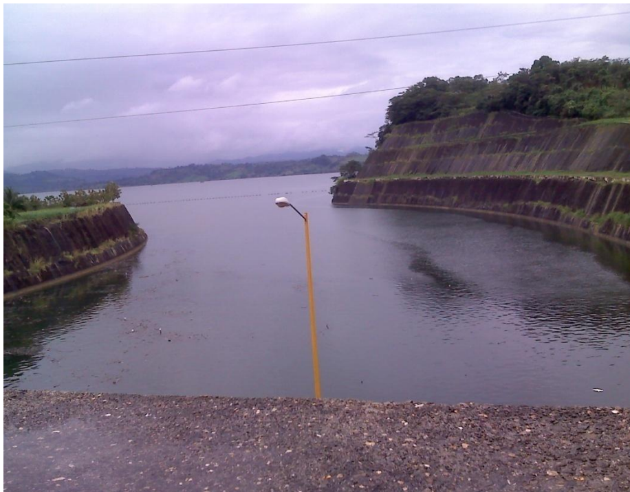
Fig 2.2.1.3.4 .- Obra de Toma
