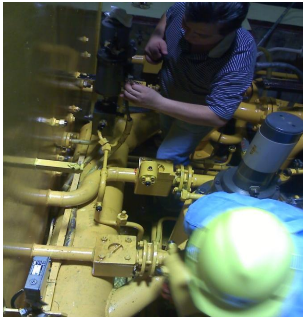
Fig 3.6.3.- Retiro de cable de señal del shut-down
