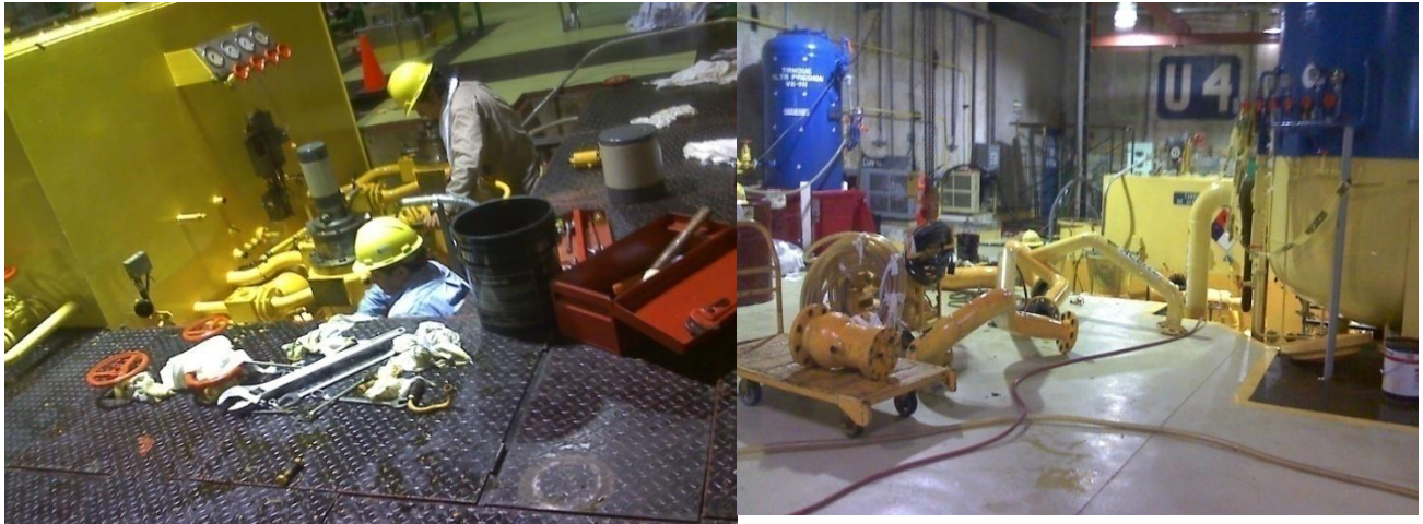
fig 3.6.1.-Desmontaje del sistema de bombeo de de aceite
