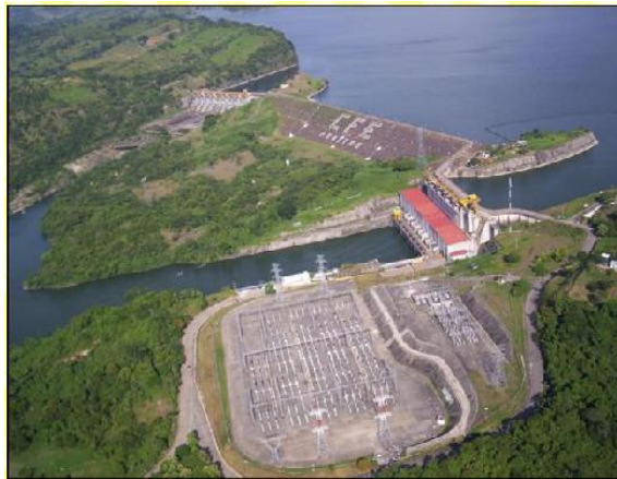
Fig 2.2.1.- CENTRAL HIDROELECTRICA "PEÑITAS"
