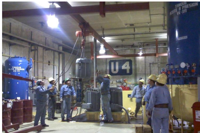
Fig 3.6.2.- Desmantelamiento de las bombas M-312,M-313,M-314
