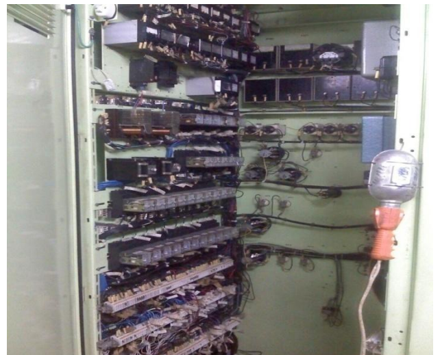
fig 3.6.4.-Gabinete DT4-4 y DT4-3 respectivamente: lógica de alarmas y disparos a base de relevadores
