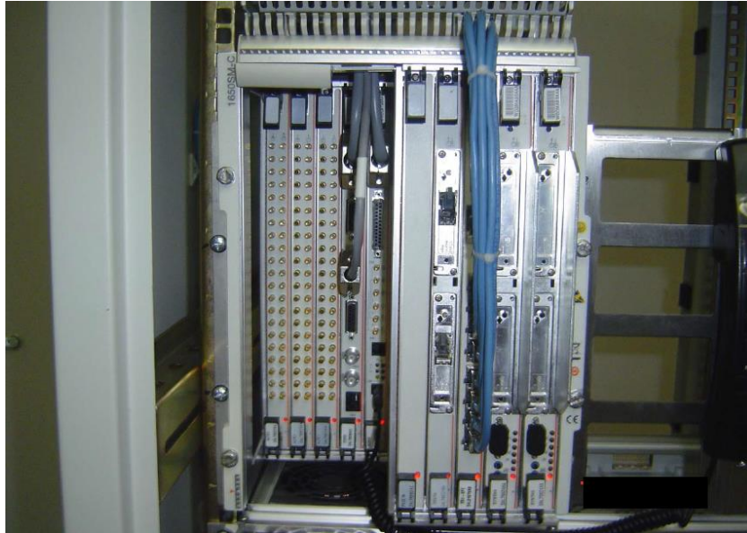
Fig. 5. Alarmas del NE 1650SM-C recién encendido.
