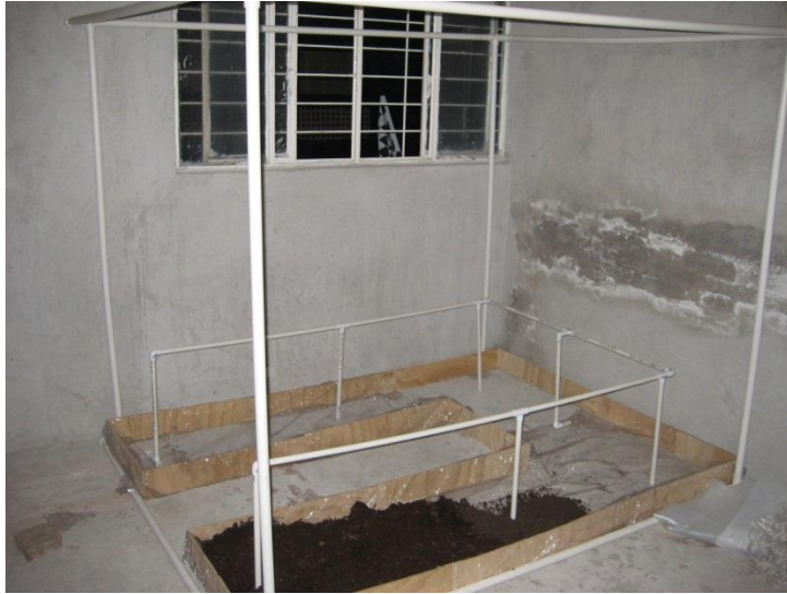
Estructura del principal del invernadero
