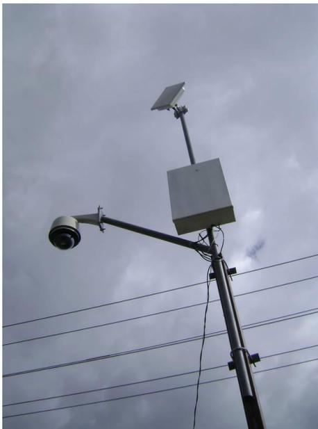
Configurado: Esto quiere decir que ya se hayan obtenido las direcciones IP de las cámaras, que los radios estén bien ubicados en su línea de vista y también deben estar configurados en cuanto a frecuencia en la que se va a transmitir, velocidad a la que va enlazar, canal por el cual se va a trabajar y algunos detalles extra que nos pide su hoja de configuración.
