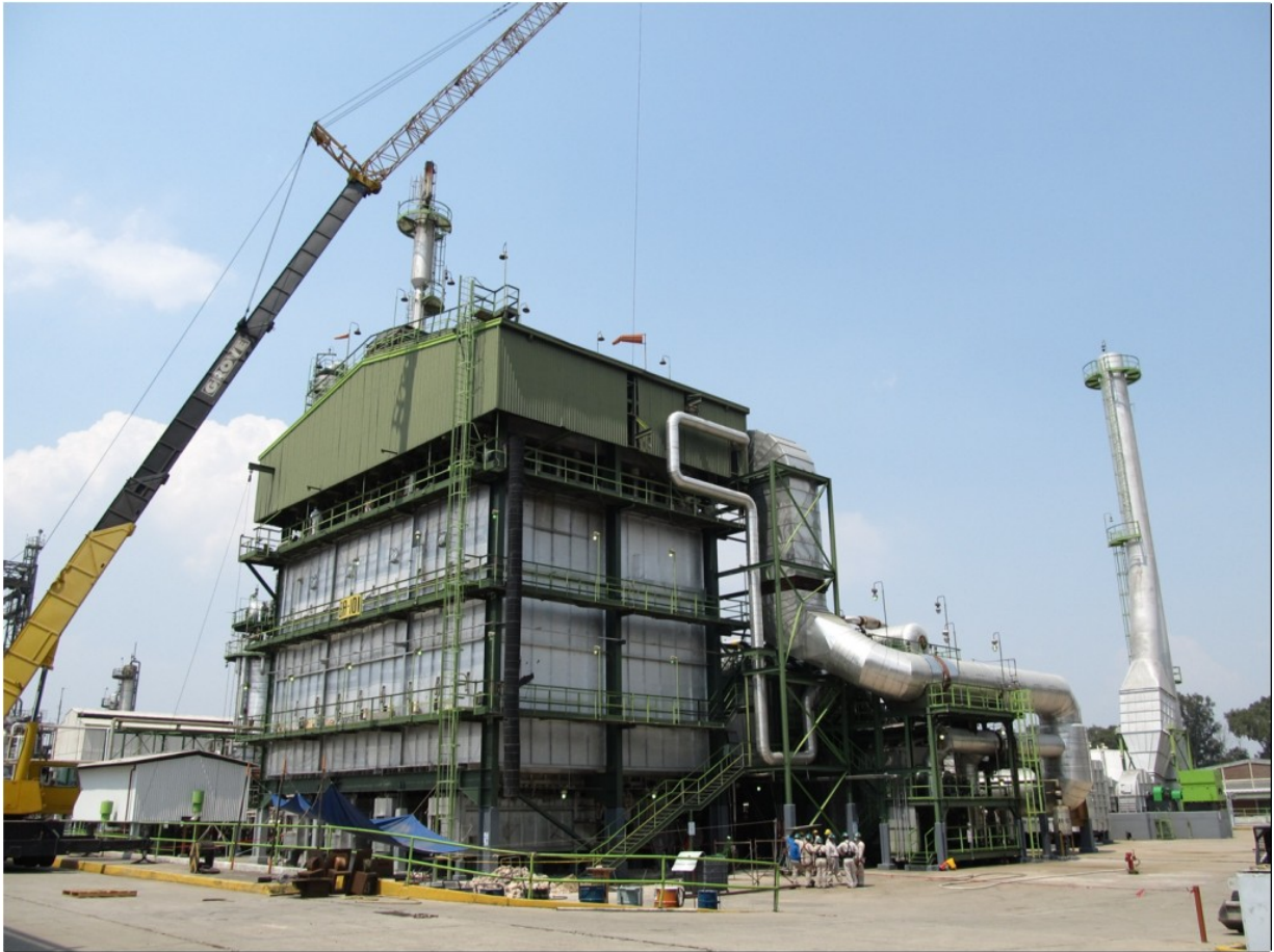
Reformador Tubular BA-101, durante el cambio de uno de sus tubos catalíticos.
