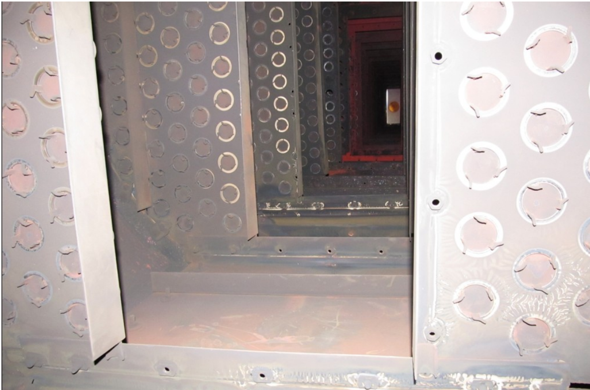
Vista Interior de una torre de Destilación de Metanol de platos con borbotadores (capuchones), en medio ha sido retirada una sección de los platos para permitir la entrada hombre.
