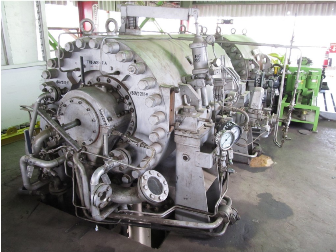
Barriles de Compresión.
