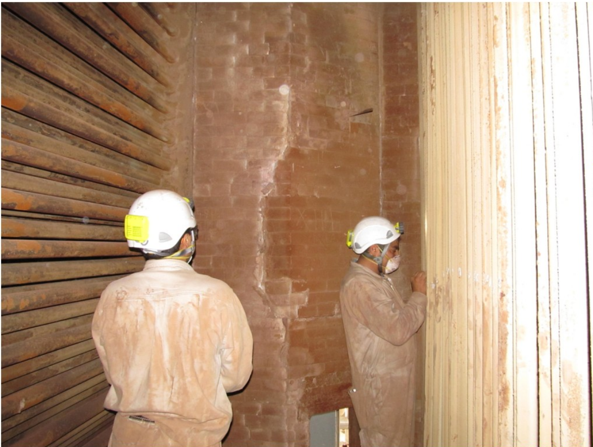
Tubos de los Intercambiadores E-105-I y E-103. Ubicados en el interior del Ducto de Recuperación del Calor de los Gases de Combustión, durante una revisión de espesores de tubo.
