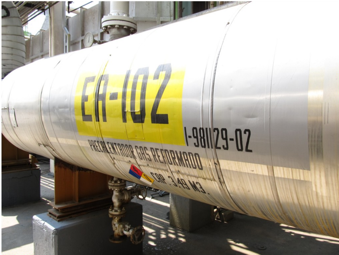
Detalle del Intercambiador de Calor EA-102 y de Información Rotulada.
