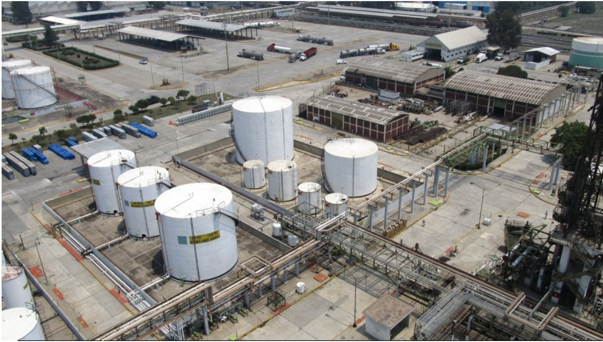
Tanques de Almacenamiento de Metanol.
