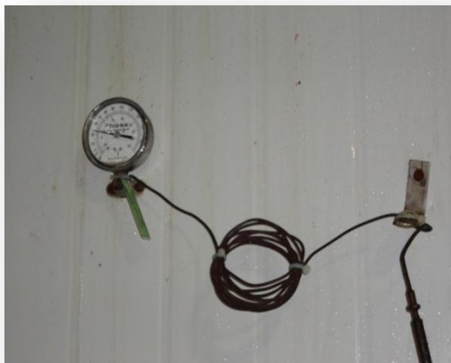
Fig. 4 Termómetros bimetalicos de capilar para la lectura de la temperatura en las cámaras de congelación.
