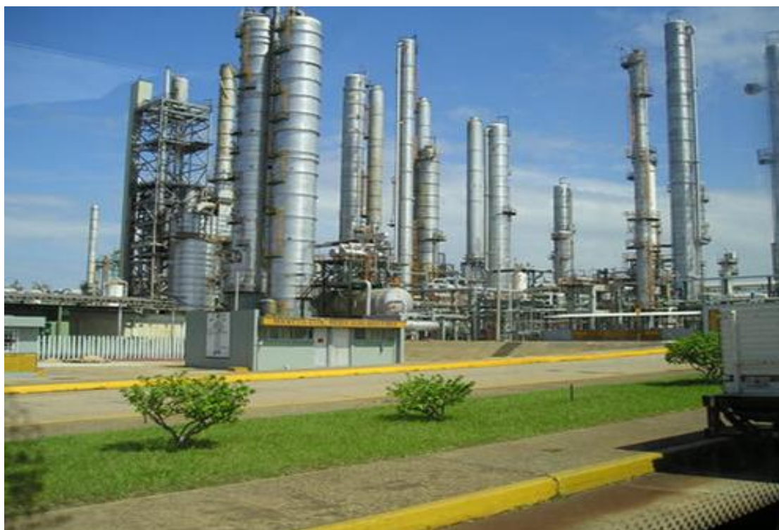
Imagen 5. Vista frontal de la planta Fraccionadora y Extractora de Aromáticos.
