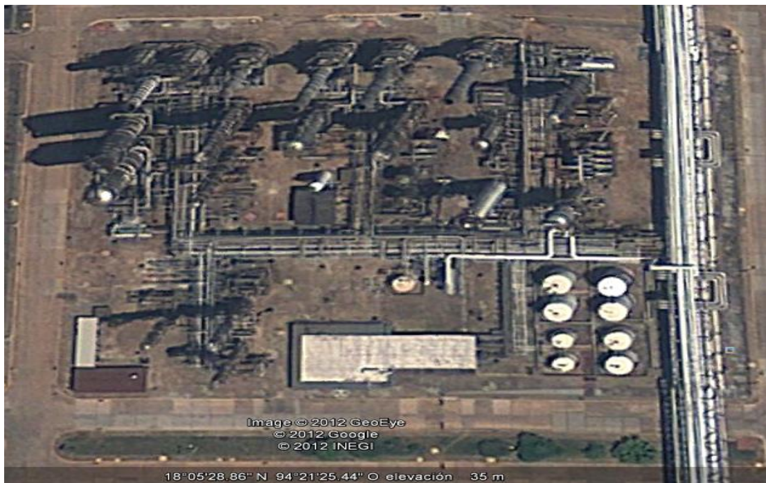
Imagen 4. Vista aérea de la planta Fraccionadora y Extractora de Aromáticos.
