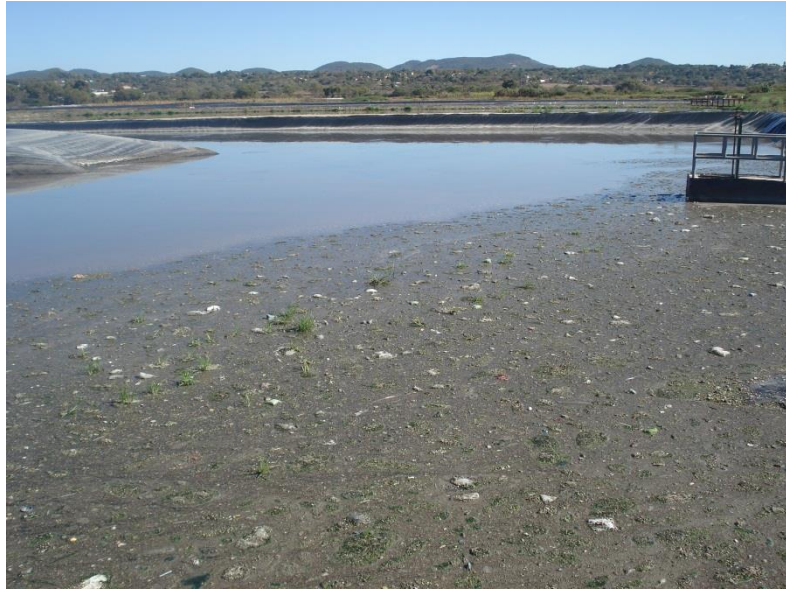
Grafico IX.2.1.1 se presenta herbaje y basura inorgánica en la laguna anaerobia del módulo “A”.
