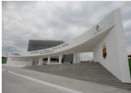
(Fig.2) Entrada principal de la institución.
