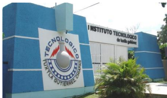
(Fig.1) Entrada principal de la institución.
