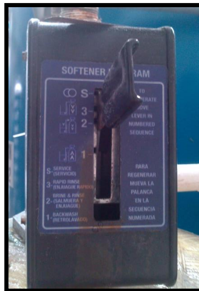
Imagen 7.4-3: Numeración de válvulas del suavizador 2.
