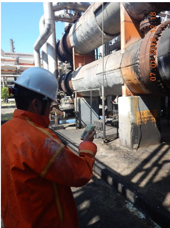
DETECTOR DE GASES EN PLANTA
