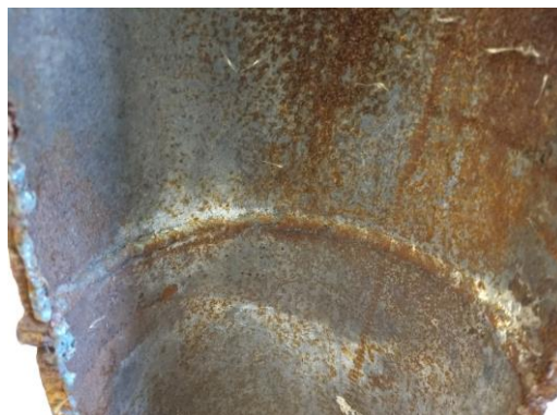
Figura 14. Imagen de la superficie interna de un ducto. Fuente: elaboración propia
