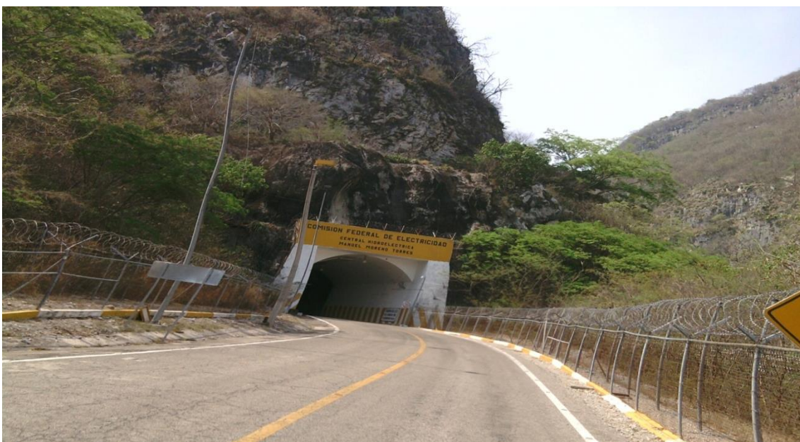
Fig. 8.- Acceso a casa de máquinas.
