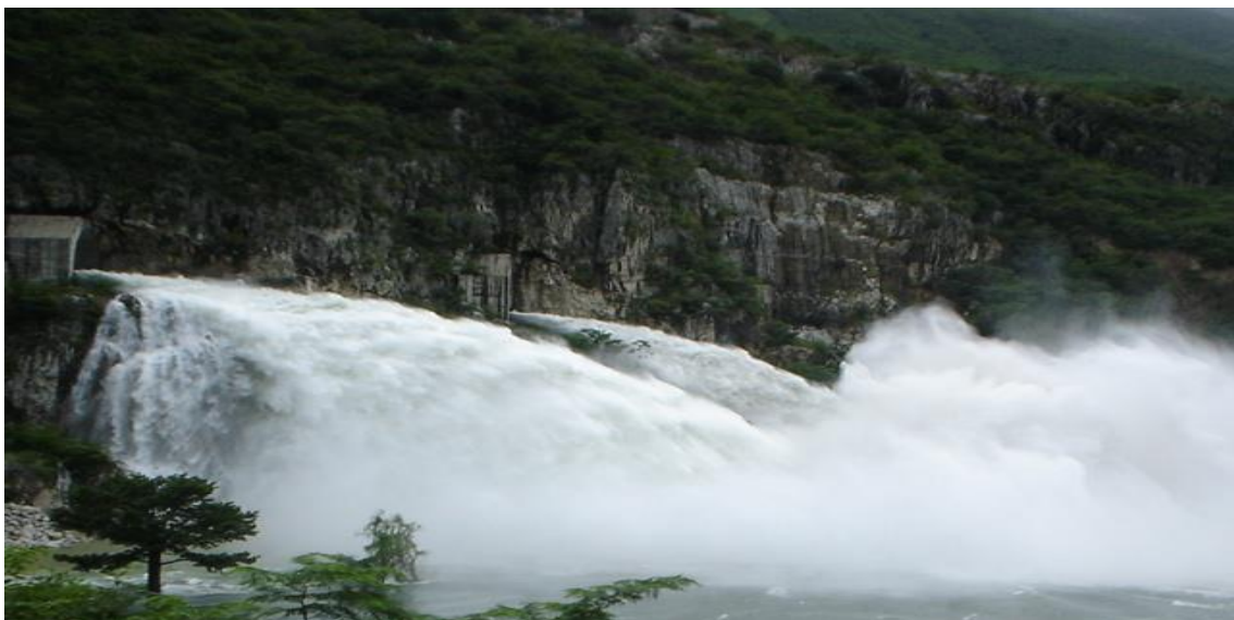
Fig.6.- Túnel de vertedores.
