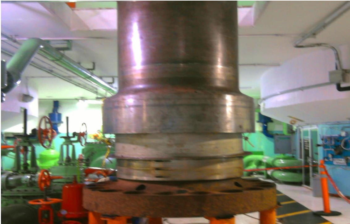
Fig.17.- Flecha de una turbina tipo Francis
