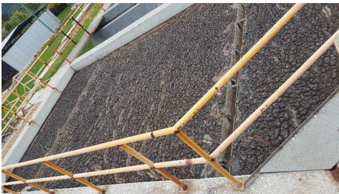
Figura 7. Reactor con exceso de sólidos
