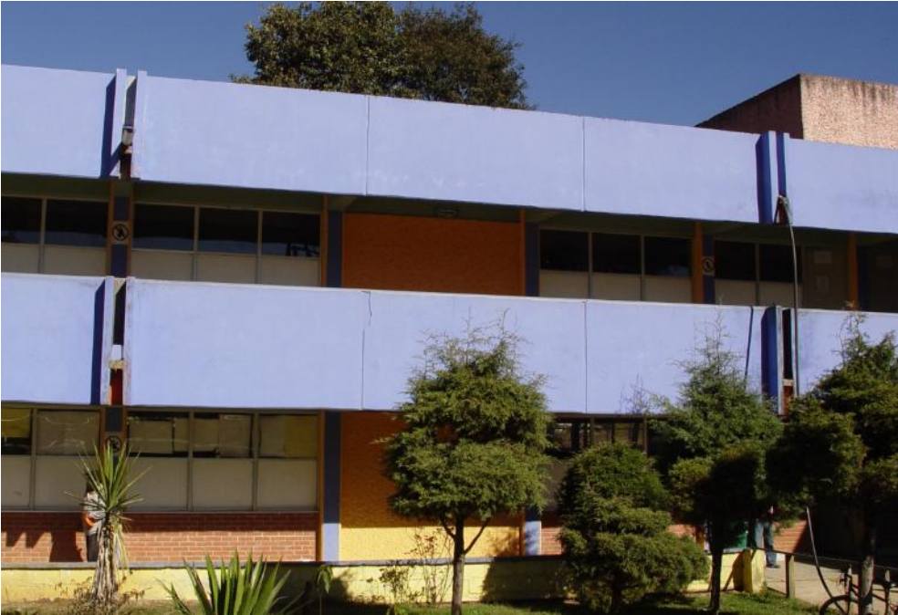
Imagen 2. Edificio A con salidas de agua pluvial.
