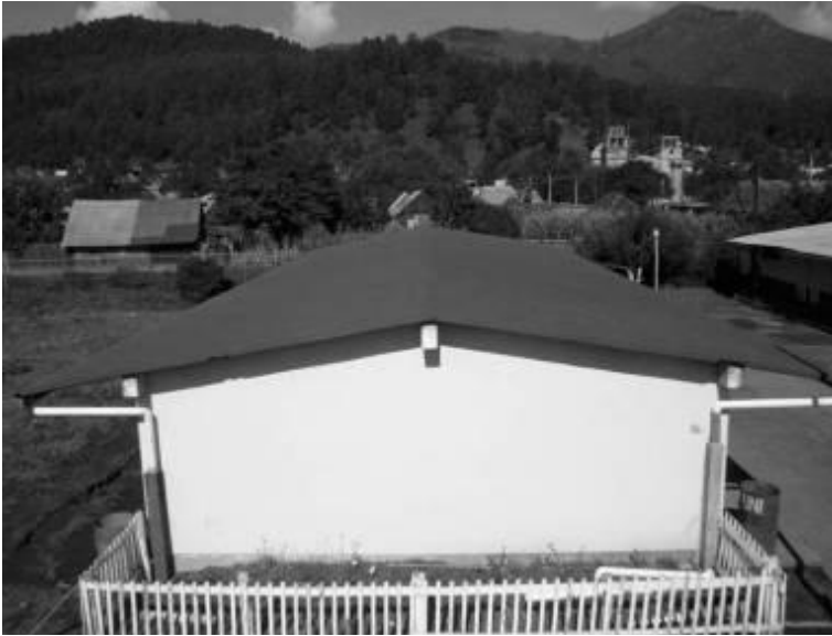
Figura 1.1 Techos de escuelas utilizados como áreas de captación del agua de lluvia, en los Reyes, Estado de Michoacán.
