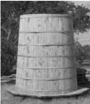
Figura 1.14 Cisterna de madera de pino con tensores para almacenar 5 m 3 .
