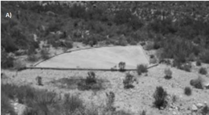
Figura 1.3 (a) Ladera recubierta con concreto en forma de abanico y (b) ladera recubierta con geomembrana de PVC acondicionados como áreas para captación del agua de lluvia.
