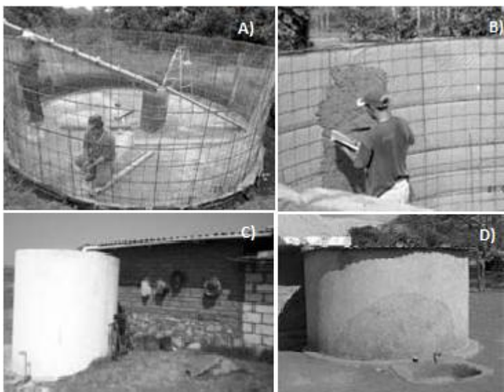
Figura 1.8 (a) Colocación de malla electro soldada ( www.bosquedeniebla.com.mx/htm/eco_cis.htm ), (b) aplanado con mezcla de arena y cemento (c) tubería de PVC cortada a la mitad para conducir el agua de lluvia a la cisterna de 10 m 3 con llave para el uso doméstico (CIDECALLI, 2006) y (d) cisterna con tapa de lámina corrugada en Uganda ( www.dip.go.ug ).
