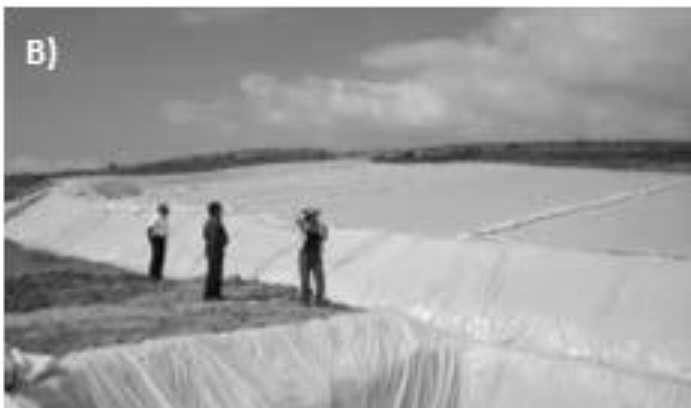
Figura 1.3 (a) Ladera recubierta con concreto en forma de abanico y (b) ladera recubierta con geomembrana de PVC acondicionados como áreas para captación del agua de lluvia.
