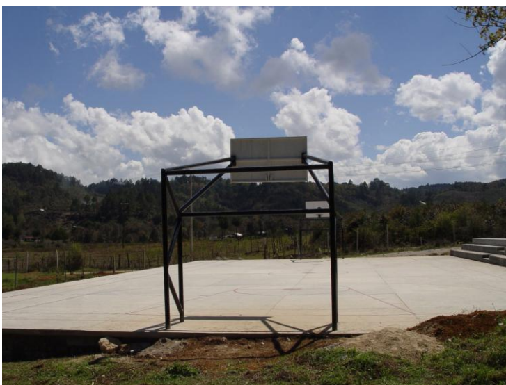
Imagen 9. Levantamiento en Cancha deportiva 2.
