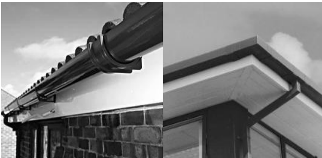
Figura 1.5 Forma de canaletas acordes a edificaciones.
