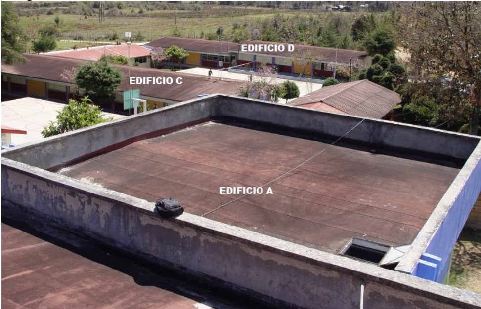
Imagen.1 Techos del Edificio A, B, C.
