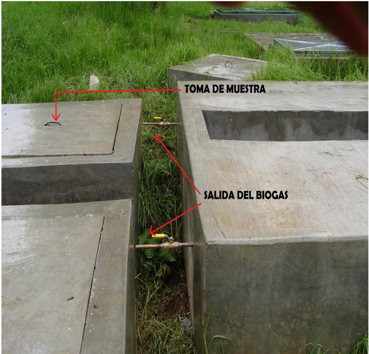
**Imagen 2. Puntos de muestras a la salida de la PTAR.**
