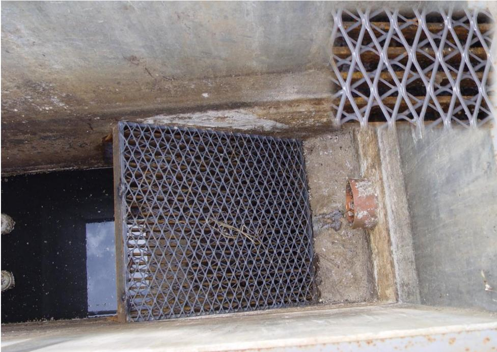
**Imagen 6. Tratamiento primario (Modificación de las rejillas).**
