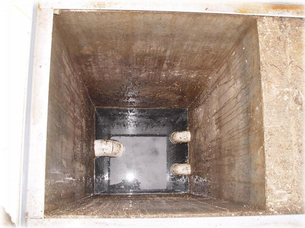
**Imagen No. 8 tratamiento primario trampa de grasas y sedimentador.**
