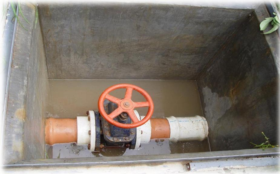
**Imagen 4 .By pass del sistema de la PTAR.**
