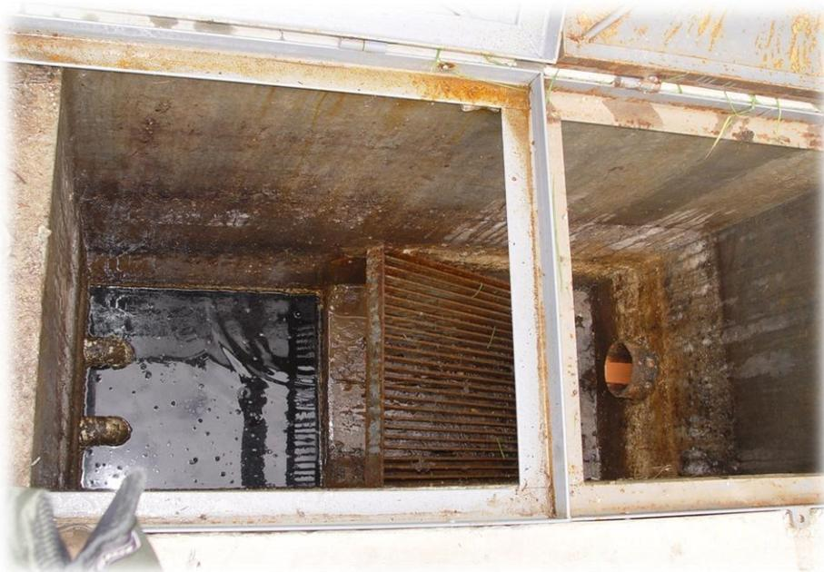
**Imagen 5 .Tratamiento primario (Trampa de grasas, rejilla y desarenador).**
