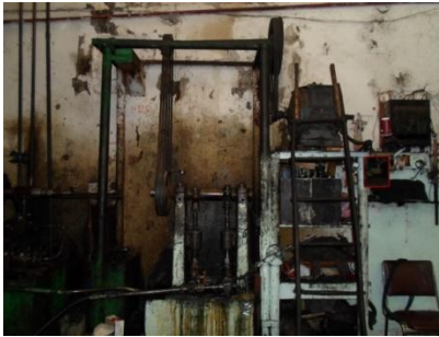
Figura 5.4 bomba y tuberías
