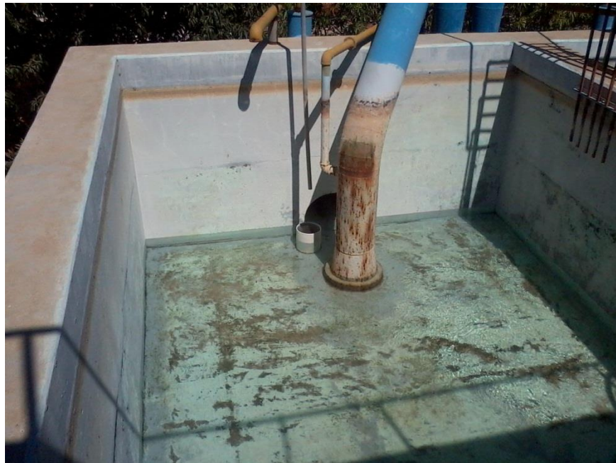
Figura6.1 Limpieza de los sedimetadores planta numero 2
