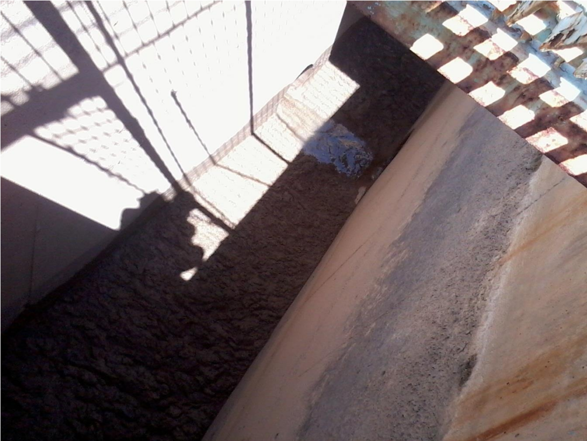
Figura 6.3 limpieza de las canaletas antes de sedimentación (después de floculación)
