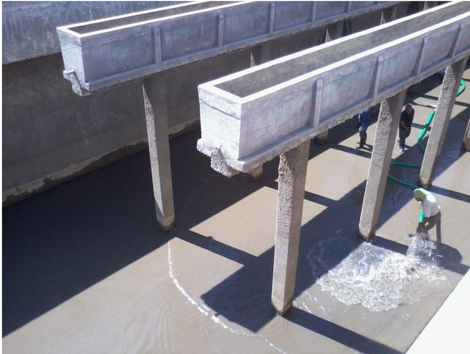
Figura6.1 Limpieza de los sedimetadores planta numero 2
