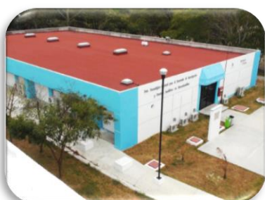
Figura 6.1 Instalaciones del Polo Tecnológico Nacional de Pruebas Analíticas en Biocombustibles (toma aérea).
