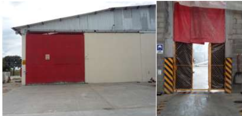
Ilustración 13. Puertas del área de producción y almacenamiento
