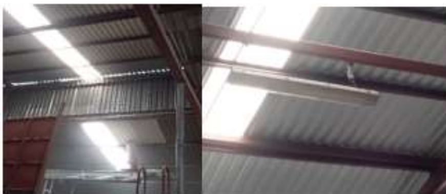
Ilustración 11. Techo del área de producción y almacenamiento
