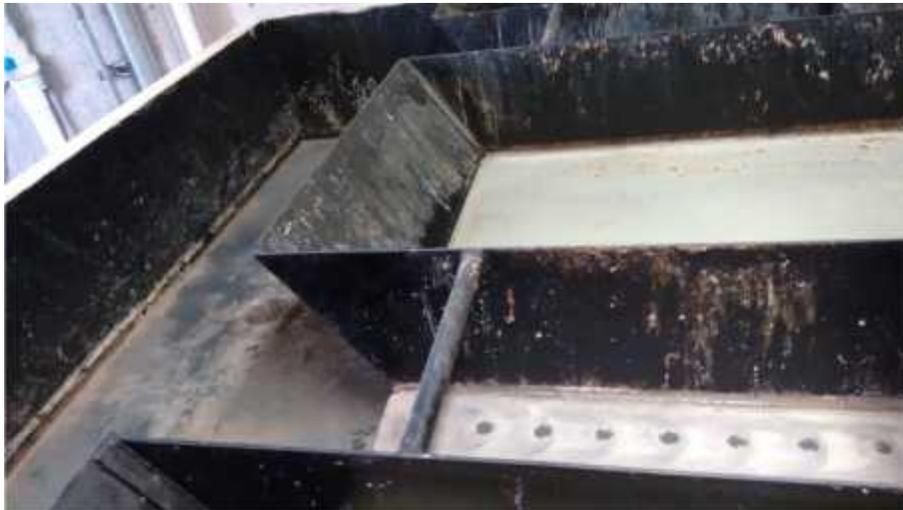
Figura 33. Lamella utilizada para el tratamiento de aguas en Virbac.
