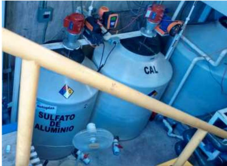
Figura 34. Tanques de preparación de mezclas de cal y sulfato de aluminio.
