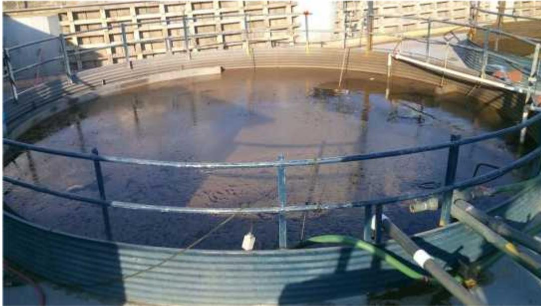
Figura 19. Clarificador con problemas de levantamiento de manto
