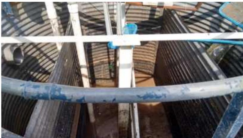
Figura 20. Clorador con lodo proveniente del clarificador.
