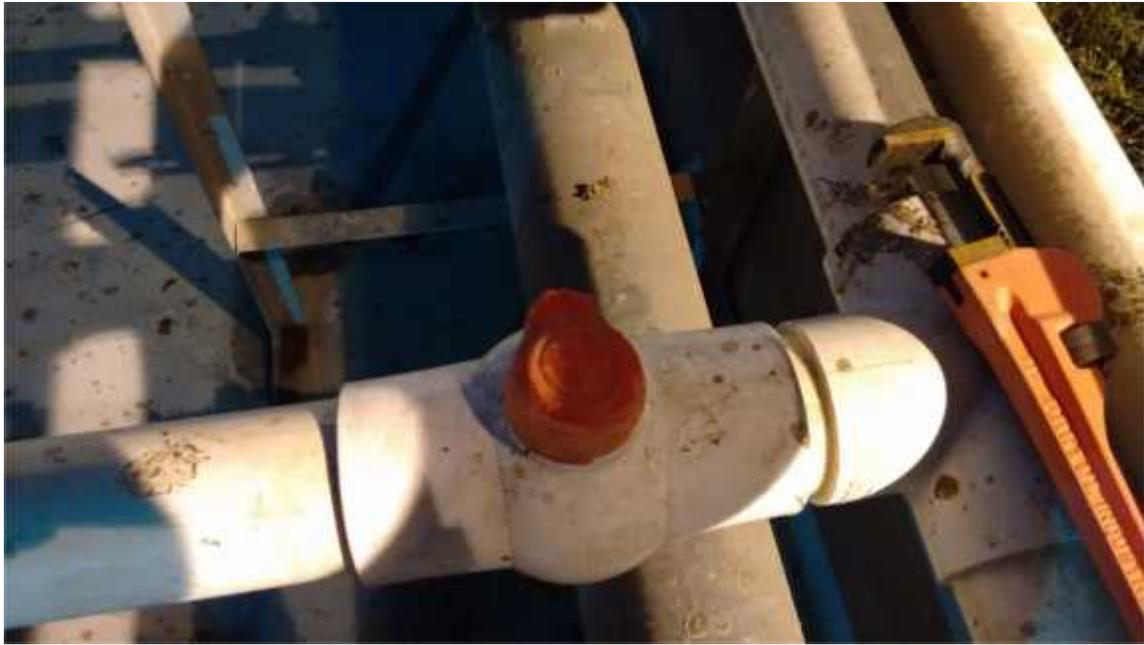
Figura 22. Válvula de purga rota.
