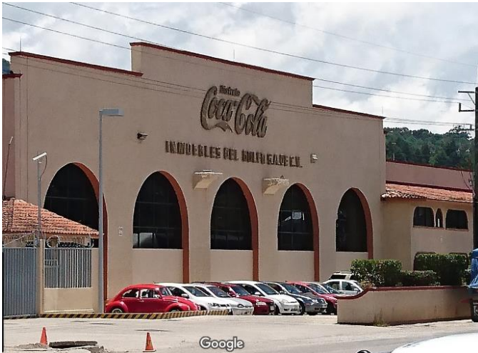
Figura 7: Fachada de la empresa.
