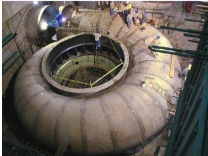
Figura 2.1. Fotografía de una carcasa espiral.
