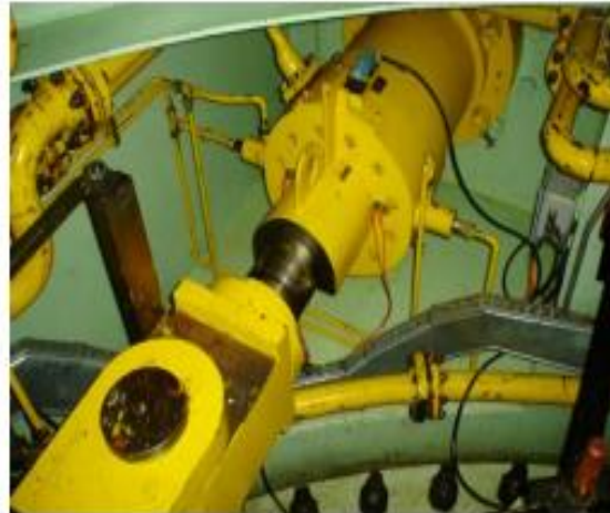
Figura 2.3. Diagrama y fotografía de un servomotor.
