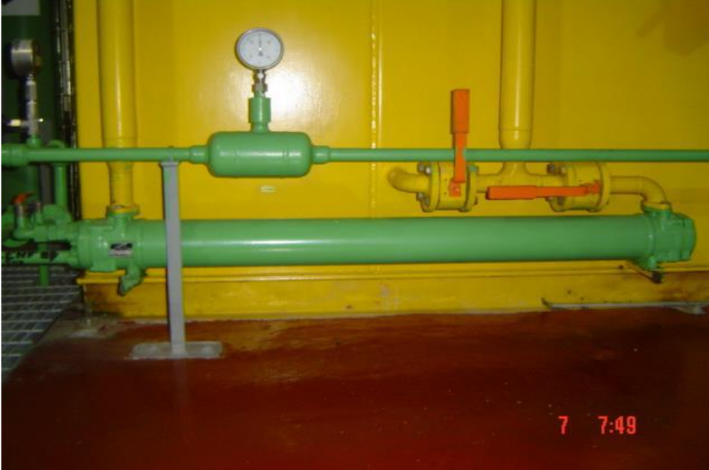
Figura 1.13. Intercambiador de calor del sistema de regulación de velocidades
