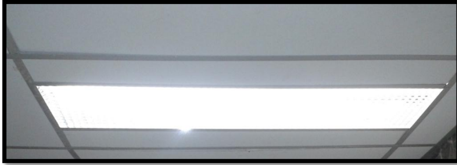
Fig.3.1 Lámpara fluorescente de 2 tubos de 32 watts, con difusor tipo rejilla y reflector convencional.
