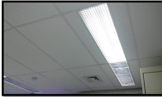
Fig.3.4 Lámpara fluorescente de 2 tubos de 60 watts, con difusor tipo rejilla y reflector convencional.
