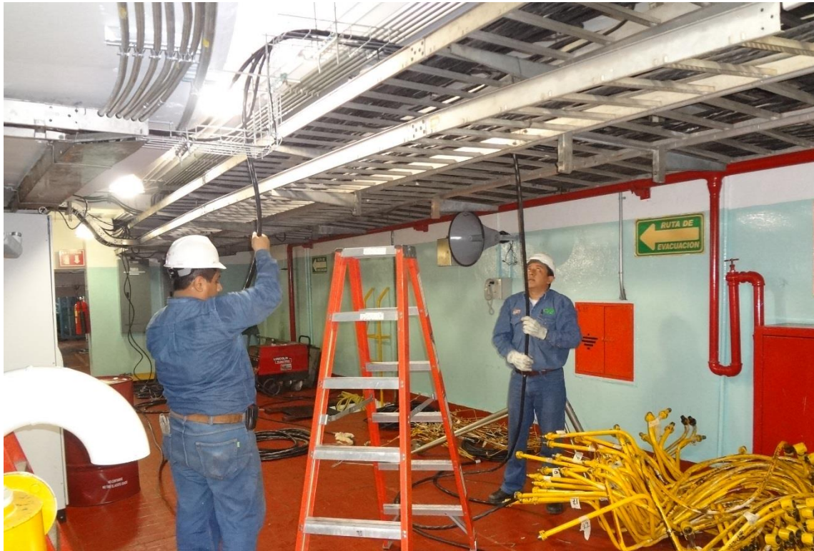
Fig. 7.56 Implementación de cableado nuevo para los equipos auxiliares.
