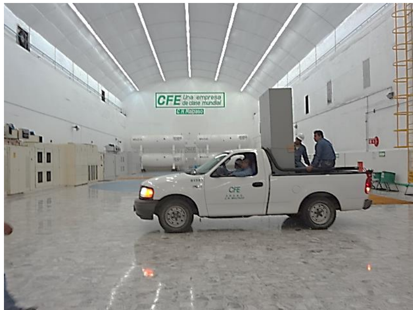
Fig. 7.46 Llegada del CCM a la planta.
