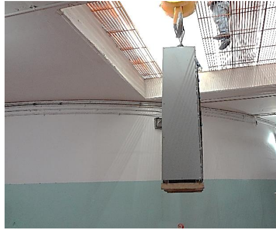
Fig. 7.48 Traslado con Grúa viajera del CCM.
