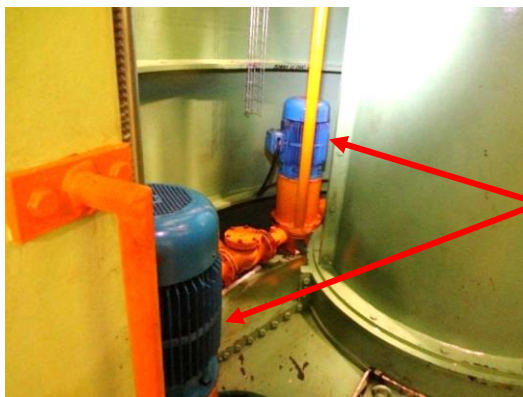
Fig. 7.28 Vista interna de la ubicación de las bombas de circulación.
