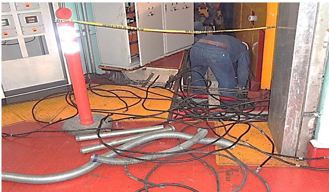
Fig. 7.55 Retiro de cable y tubería antigua.
