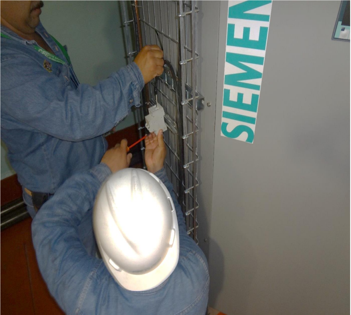
Fig. 7.65 Conexión de interruptor para protección del CCM.
