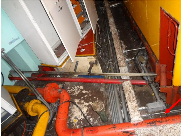
Fig. 7.20 Tubería de paso a los servomotores.
