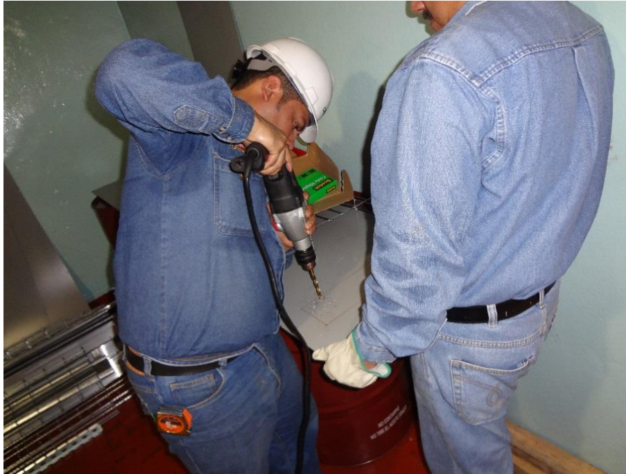
Fig. 7.52 Corte y perforación de las charolas.
