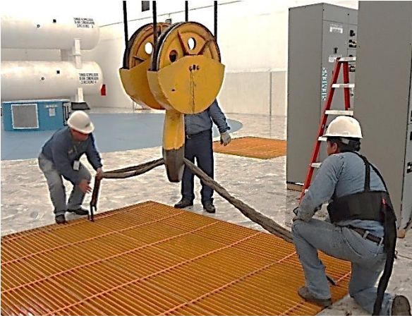
Fig. 7.47 Desalojo de rejillas.
