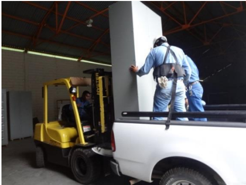
Fig. 7.44 Retiro del CCM del almacén.
