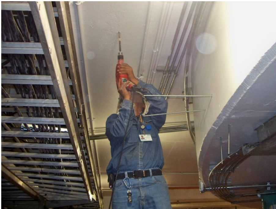
Fig. 7.53 Perforación del techo para el ajuste de las rejillas.
