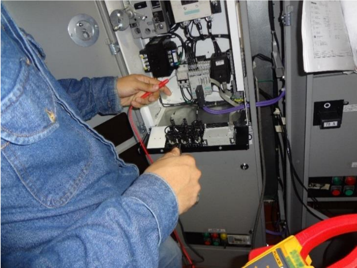
Fig. 7.57 Chequeo de corriente con amperímetro.
