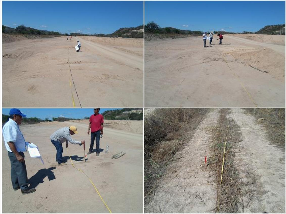
**Figura 3.2. Trazo y estacado de línea**
