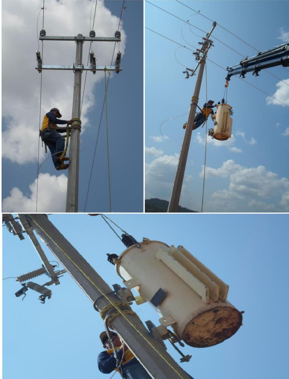
**Figura 3.33. Instalación del transformado tipo poste**
