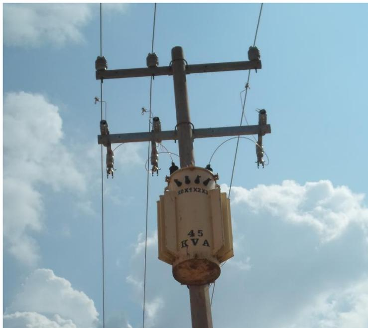
**Figura 3.34. Transformador tipo poste.**
