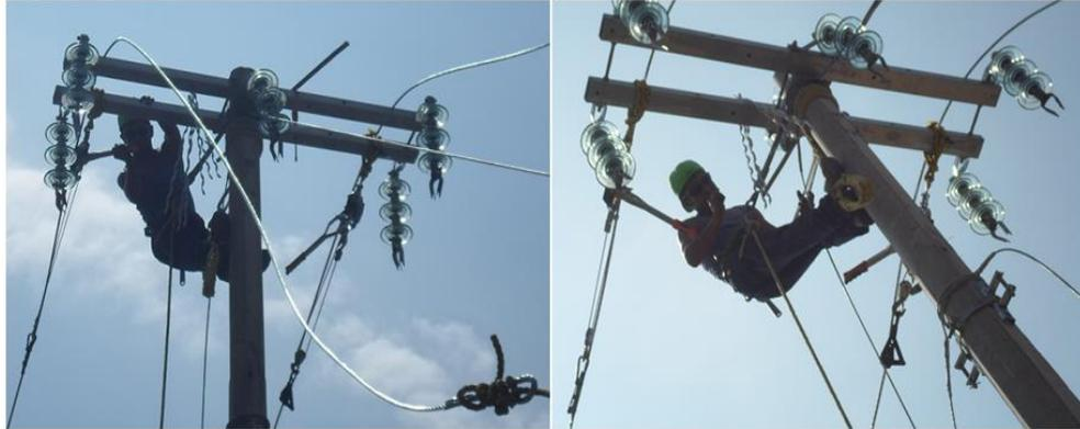
**Figura 3.28. Tensado de conductor con el malacate m-2.**
