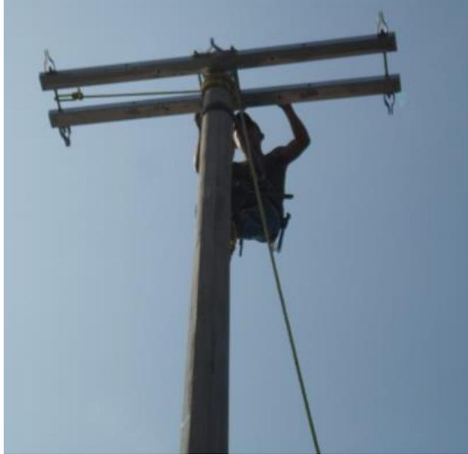
**Figura 3.18. Sujeción de las crucetas PR200.**
