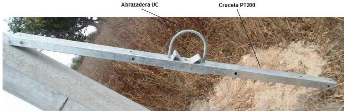
Figura 3.8. Ensamble de la abrazadera.
