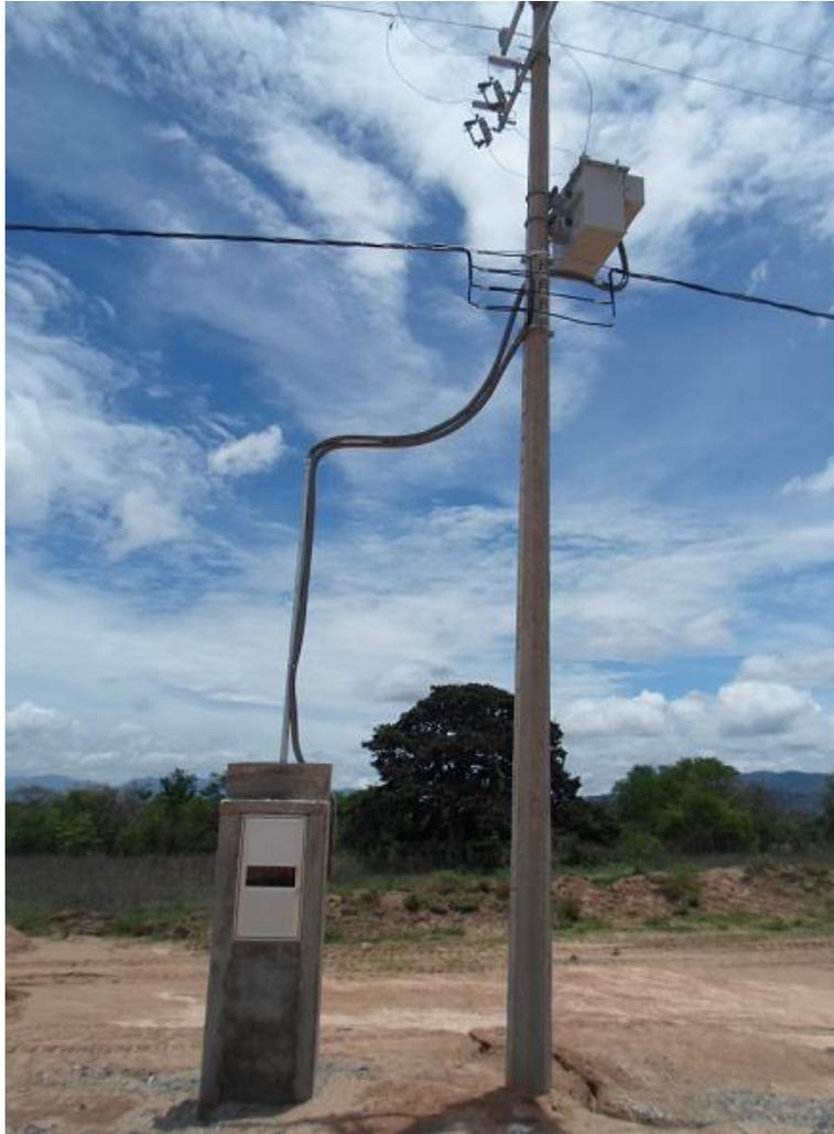
**Figura 3.39. Murete de medición con acometida.**
