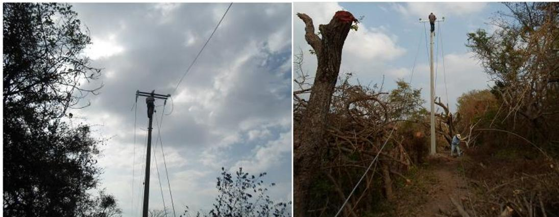
**Figura 3.29. Tendido y remate del conductor**
