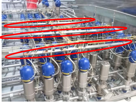
Figura 3.14 Distribución de aire comprimido en el clúster
