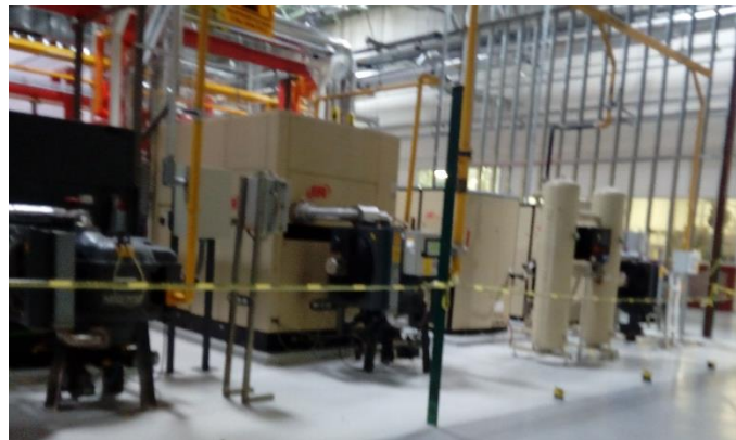
Figura 3.10 sistema compresores
