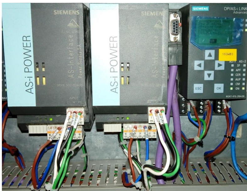
Figura 3.5 Fuentes ASI-bus y Gateway
